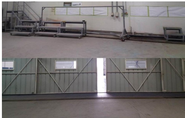
Figura N°15: Canal de tuberías y drenaje de agua
