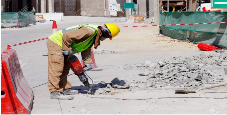
GRÁFICO N 21: DEMOLICION DE PAVIMENTOS
