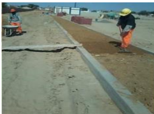
GRÁFICO N 31: COMPACTACION DE BASE DE AFIRMADO PARA VEREDAS
