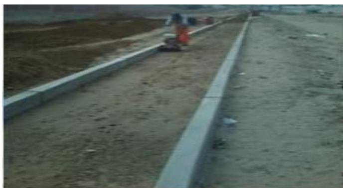
GRÁFICO N 30: COLOCACION DE SUB BASE DE HORMIGON
