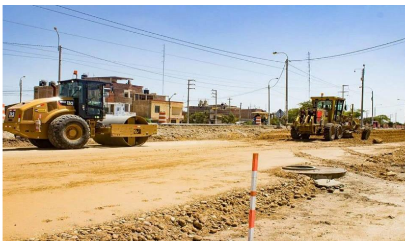
GRÁFICO N 27: COMPACTACION AFIRMADO
