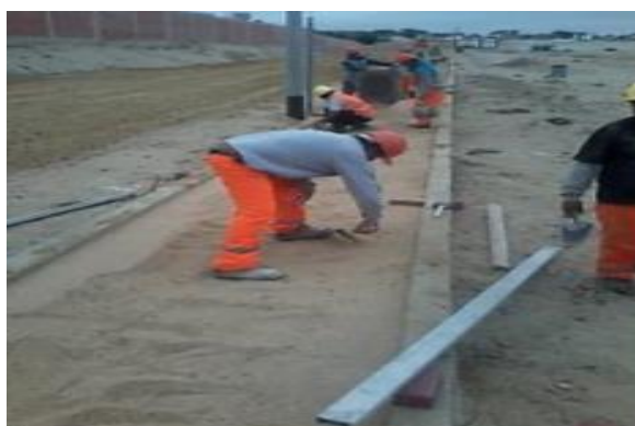
GRÁFICO N 32: COLOCACION DE CAMA DE ARENA PARA ADOQUINES
