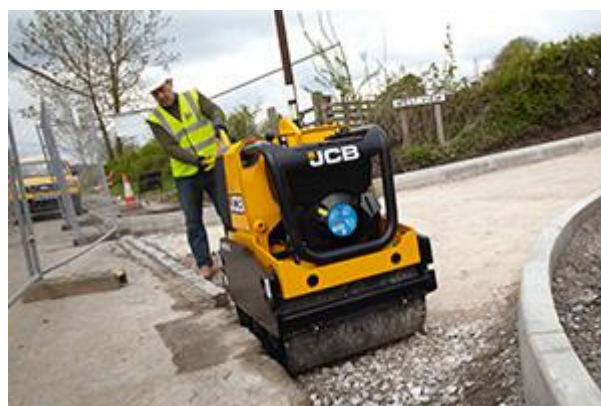
GRÁFICO N 25: COMPACTACION CON PLANCHA 4 HP
