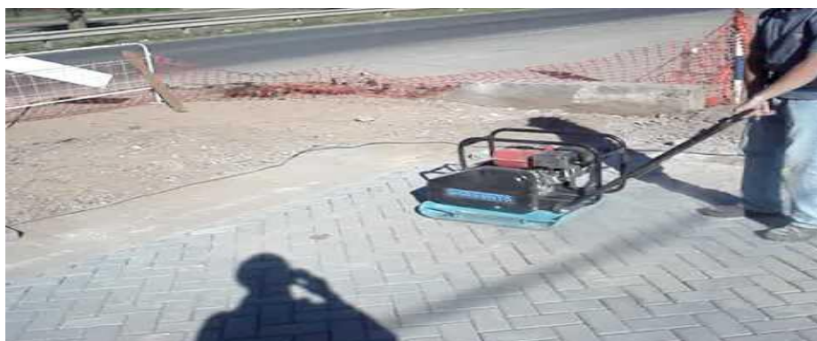
GRÁFICO N 42: COMPACTACION DE ADOQUINES EN OBRA
