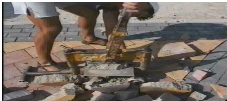
GRÁFICO N 41: CORTE DE ADOQUINES EN OBRA
