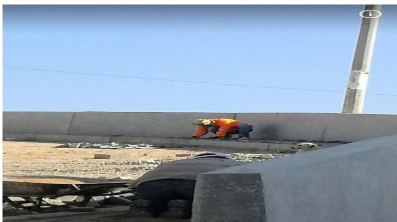
GRÁFICO N 43: COLOCACION DE ADOQUINES EN OBRA
