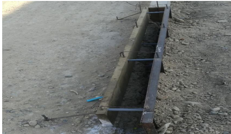
GRÁFICO N 35: ENCOFRADO DE SARDINEL
