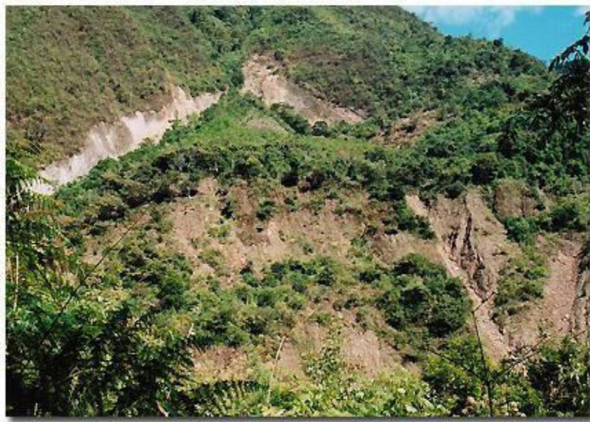
Imagen N° 001: Derrumbe en el sector del río Aobamba
