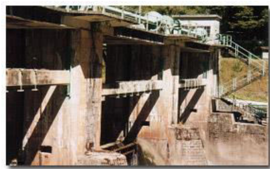
Imagen N° 021: Dique de la planta hidroeléctrica
