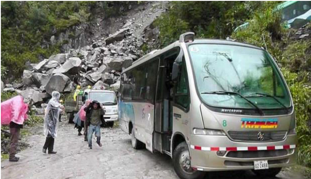
Imagen N° 017: En esta imagen se aprecia en el kilómetro 3.5 de la vía carrozable de Aguas Calientes hacia Machu Picchu
