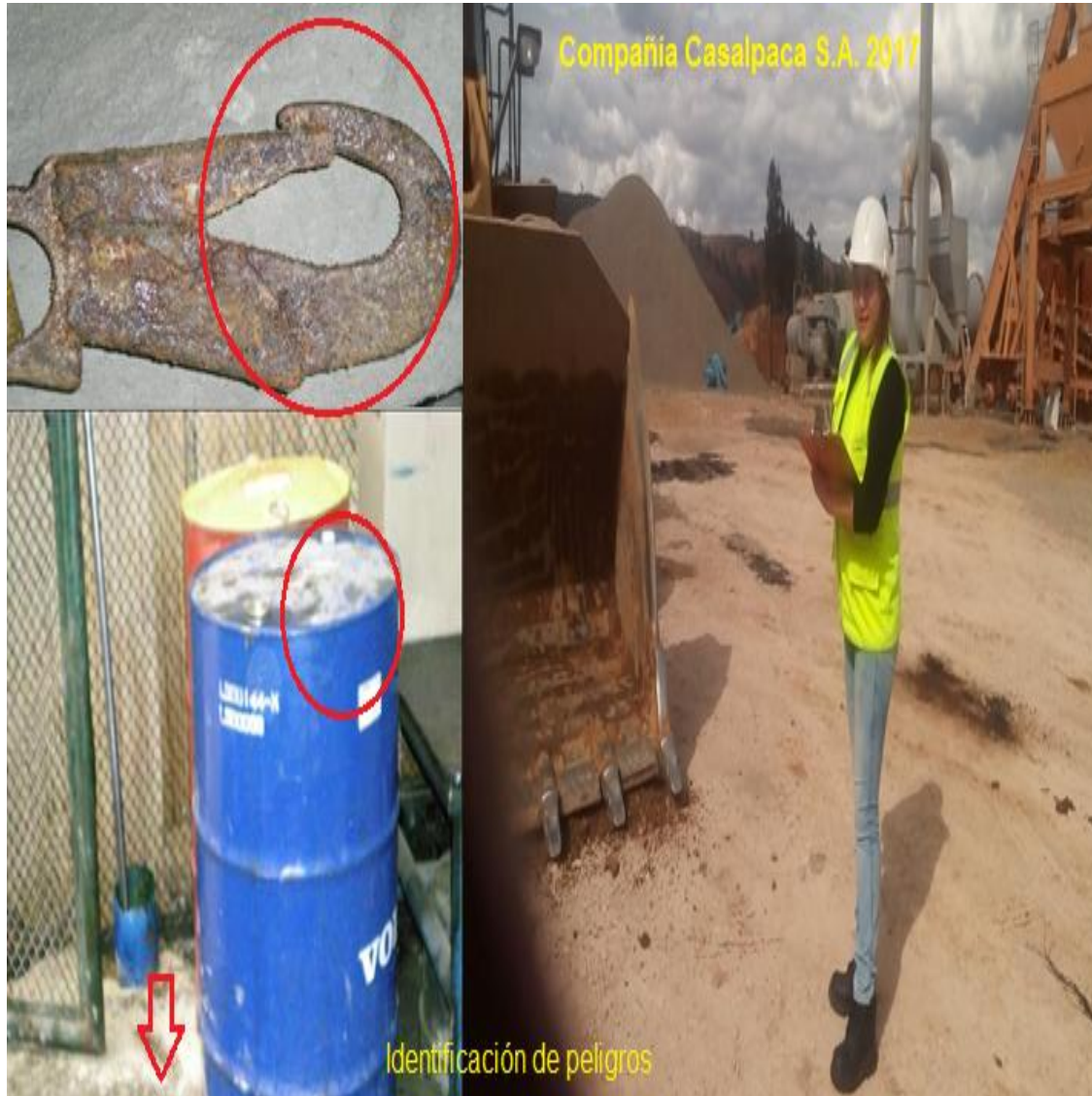
Figura 68. Identificación de peligros área de mantenimiento Fuente: Información Casalpaca, 2017.
