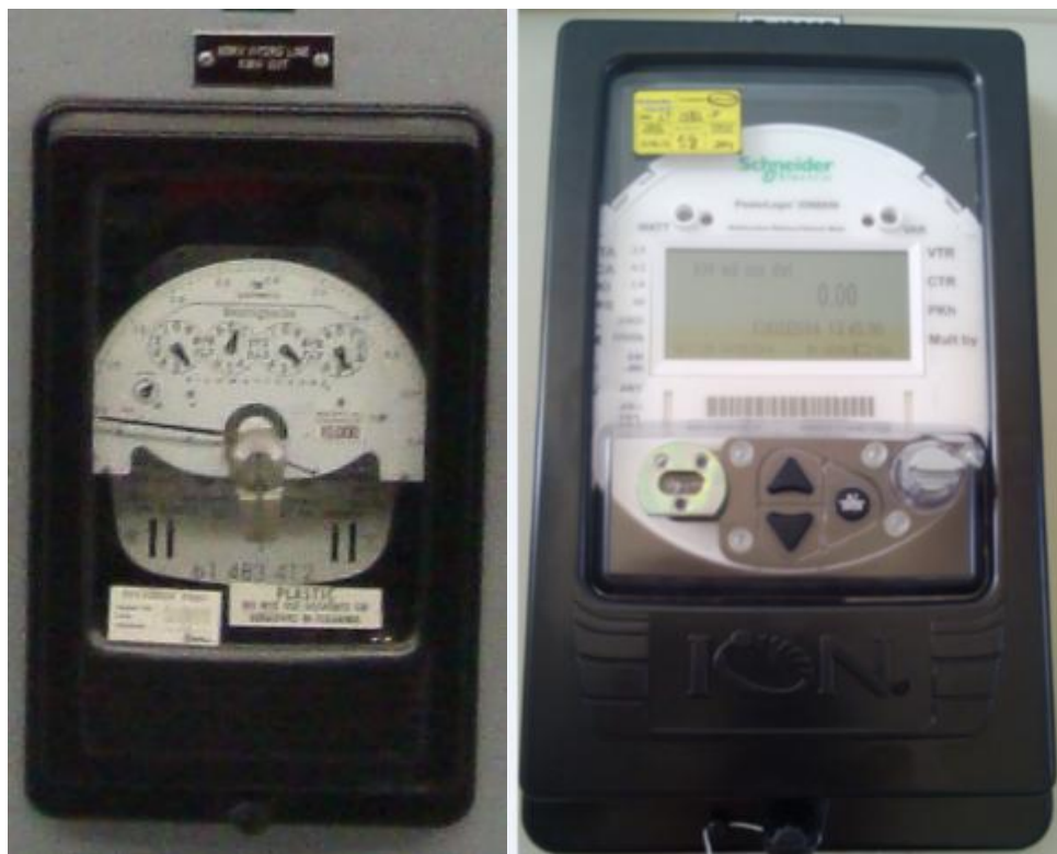
Figura 5: Reemplazo de medidores de energía
