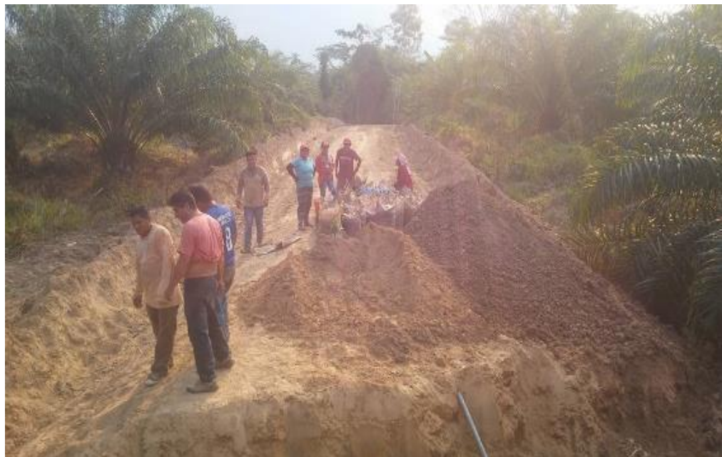
Gráfico N° 8: Movimiento de tierras para el encauzamiento de las zanjas naturales de las carreteras al interior de la plantación de palma aceitera en la empresa Agropecuaria Rossel
