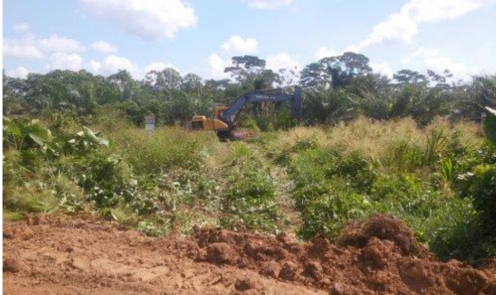
Foto N° 5: Fue necesario habilitar nuevas vías para mejorar la transitabilidad
