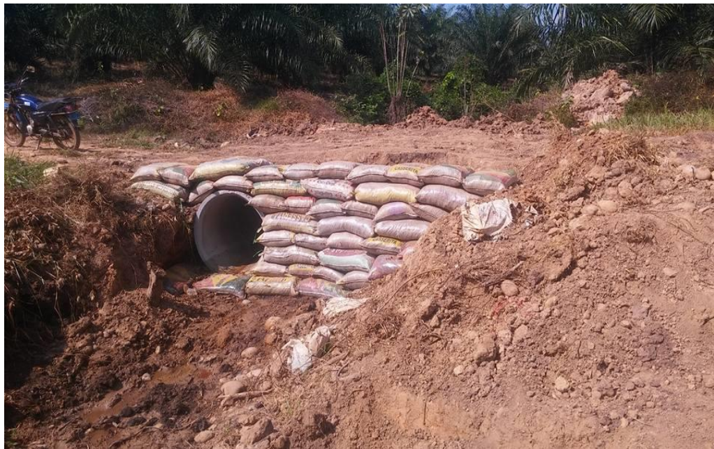
Gráfico N° 10: Colocación sacos de arena como cabezales para la construcción de puentes en las carreteras al interior de la plantación de palma aceitera en la empresa Agropecuaria Rossel
