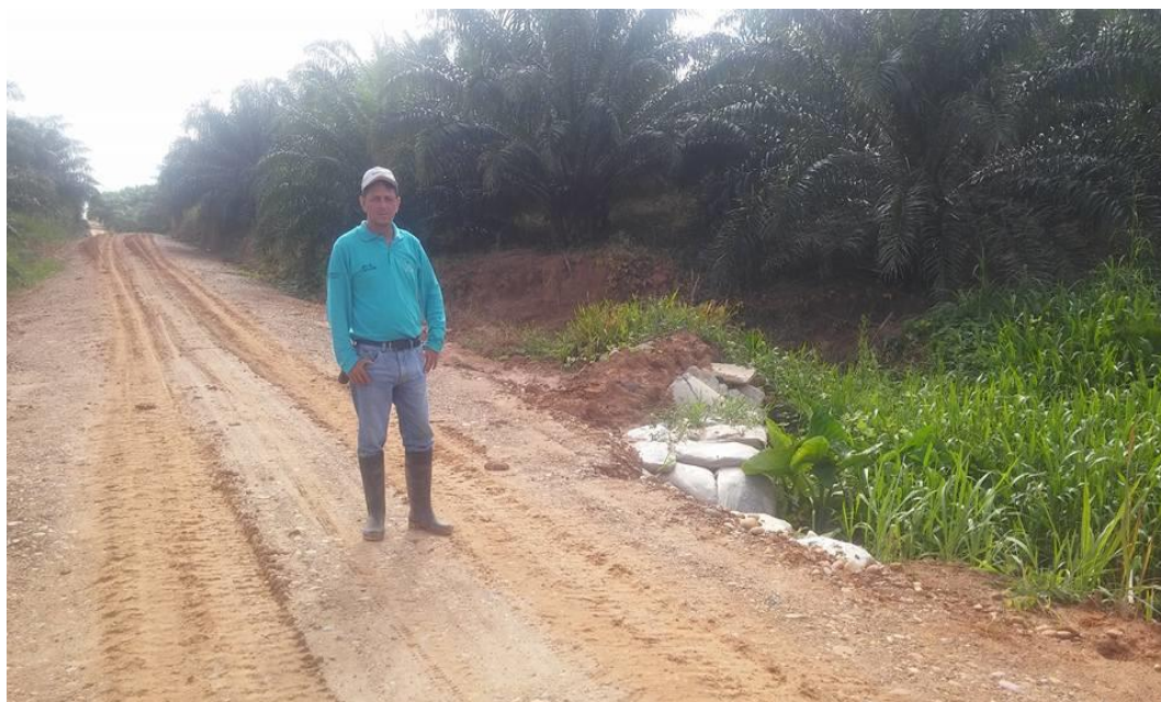
Gráfico N° 13: Carreteras con adecuadas condiciones de transitabilidad al interior de la plantación de palma aceitera en la empresa Agropecuaria Rossel
