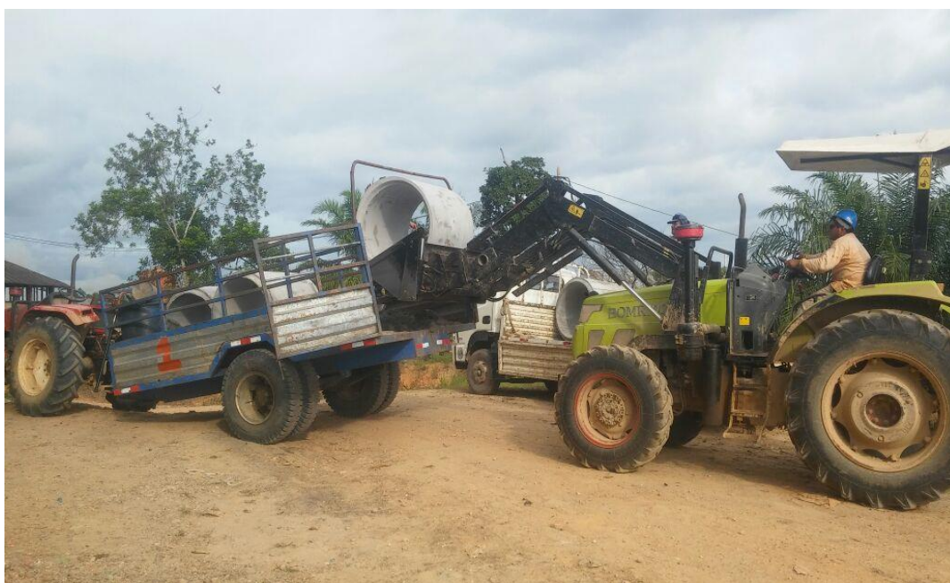
Foto N° 8: El transporte de materiales requirió la intervención de maquinaria pesada.
