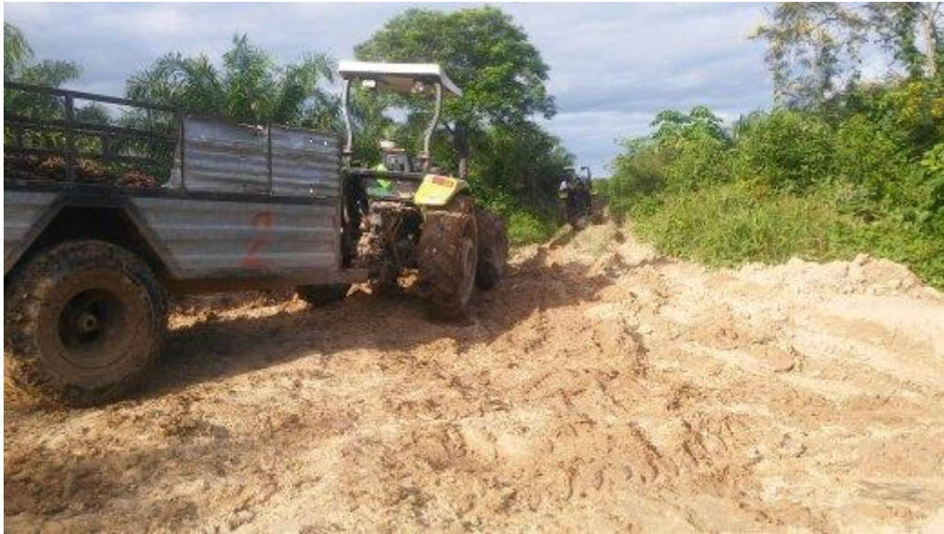
Foto N° 3: Las partículas muy finas de la superficie del suelo aceleraron el deterioro de las vías
