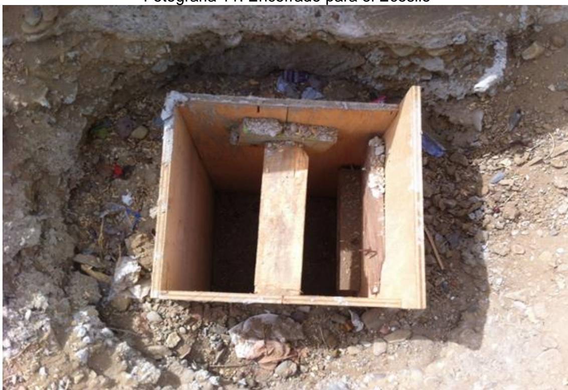
Fotografía 11: Encofrado para el Ecosilo
