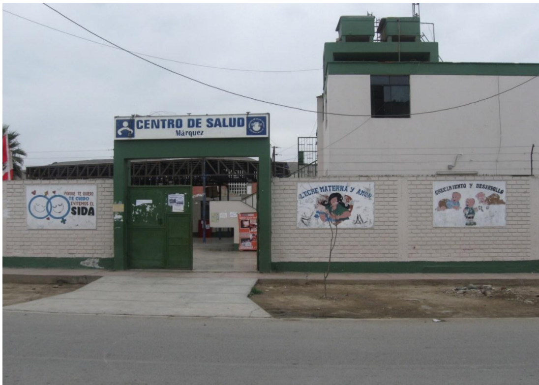
Foto N° 1: Fachada del Centro Salud Materno Infantil MARQUEZ
