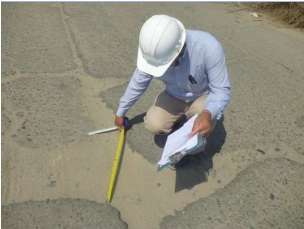
BACHEO EXTREMO SOBRE LA CAPA GRANULAR
