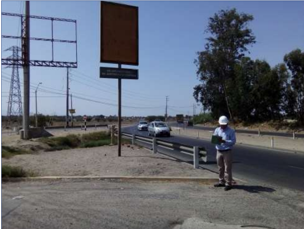
TRAMO INICIAL: PUENTE LOS MESTROS
