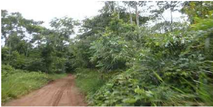
Proceso de ejecución de la obra.
