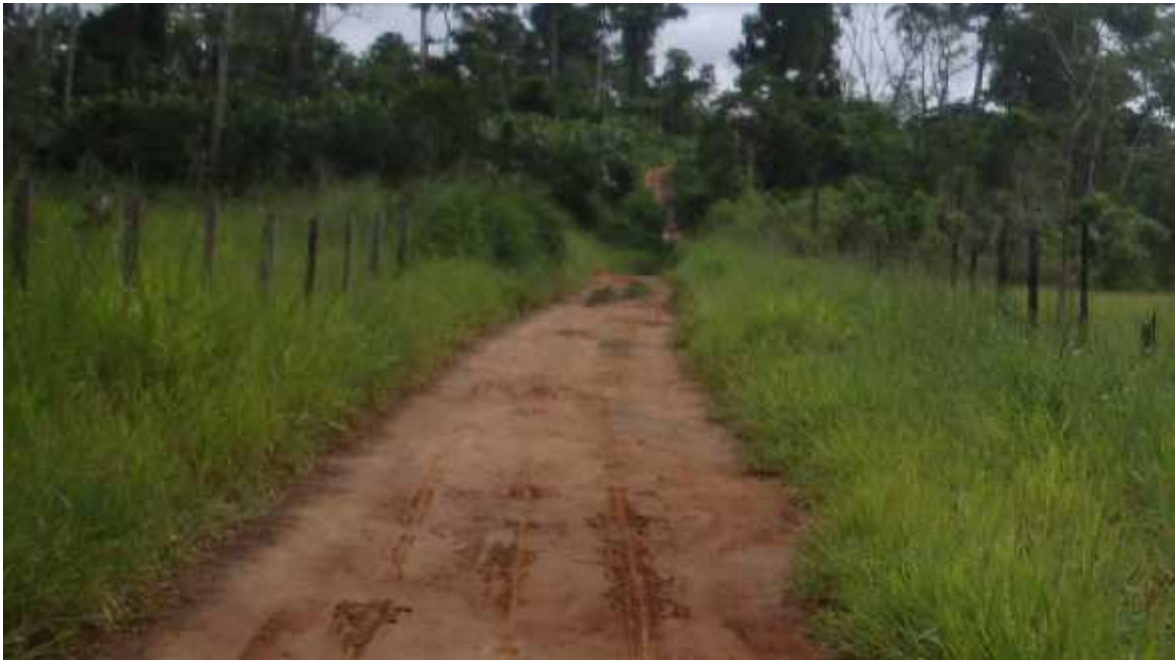
Fuente: Vista en el Km. 2+000 del Camino vecinal Desvío Km 21.5 – Nueva alianza - Gamitana.
