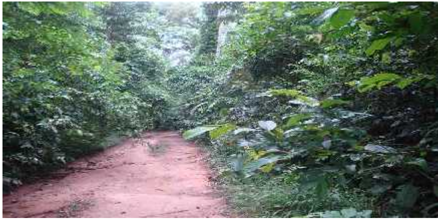
Proceso de ejecución de la obra.
