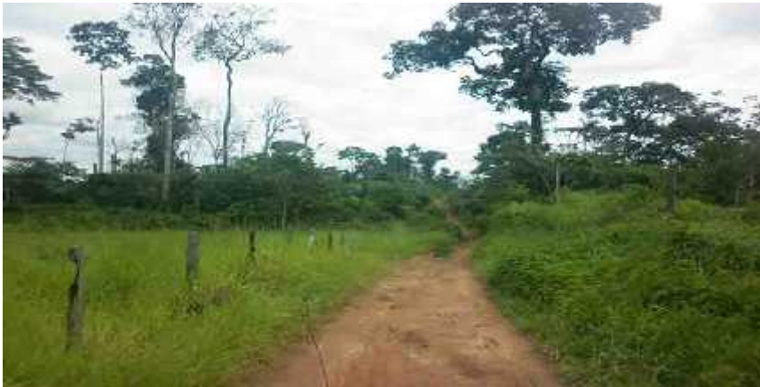
Proceso de ejecución de la obra.
