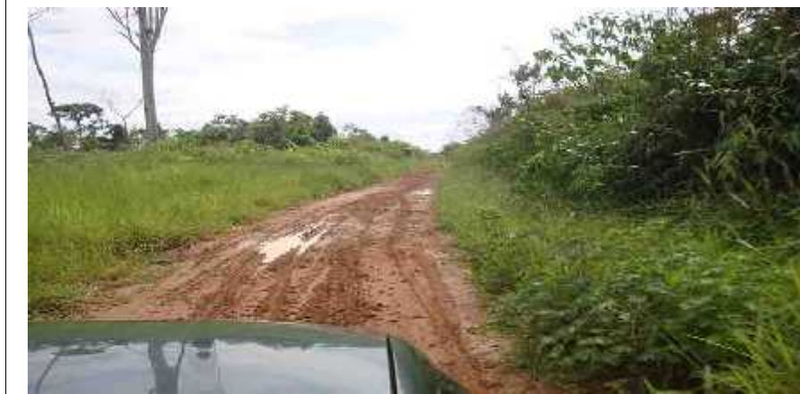
Proceso de ejecución de la obra.
