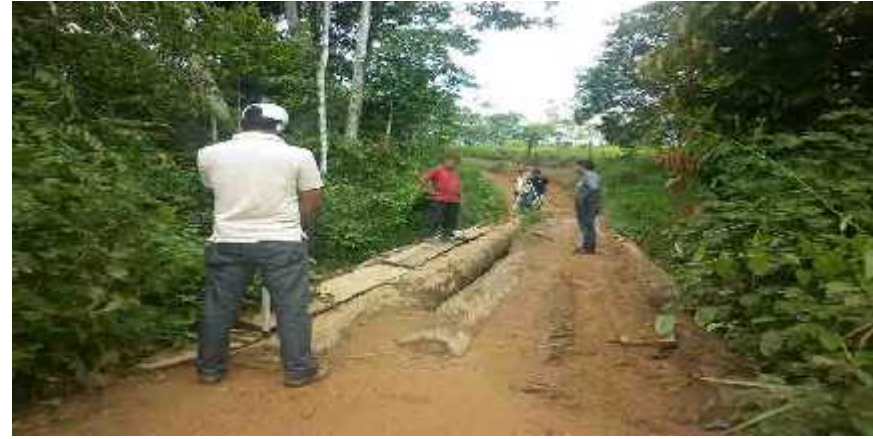
Proceso de ejecución de la obra.
