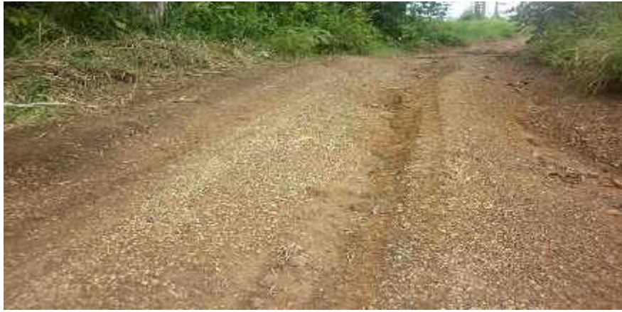
Proceso de ejecución de la obra.
