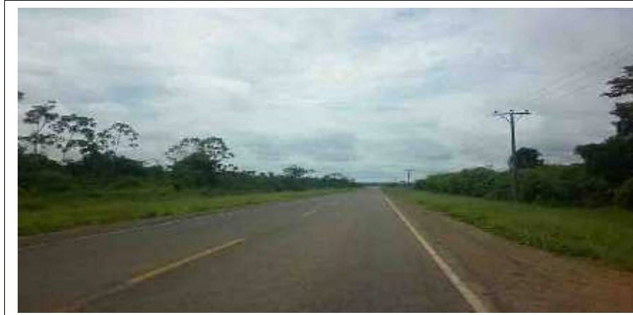
Proceso de ejecución de la obra.
