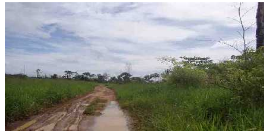
Proceso de ejecución de la obra.
