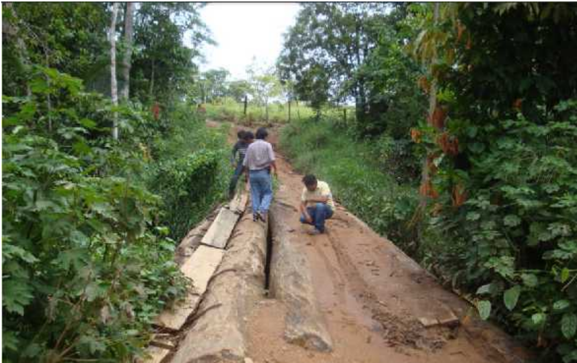
Fuente: Vista del Puente de madera de Km. 2+890 del Camino vecinal.
