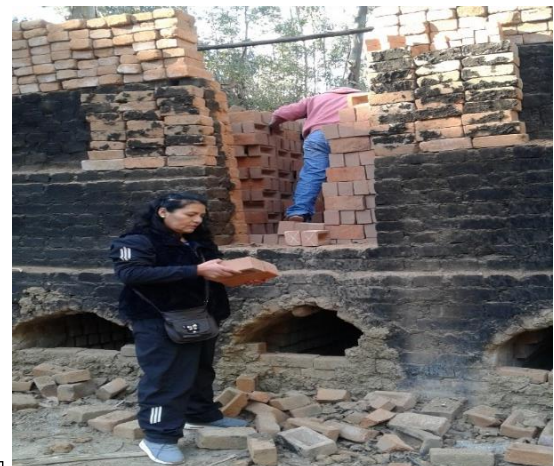
DESCARGA DE LADRILLOS COCIDOS
