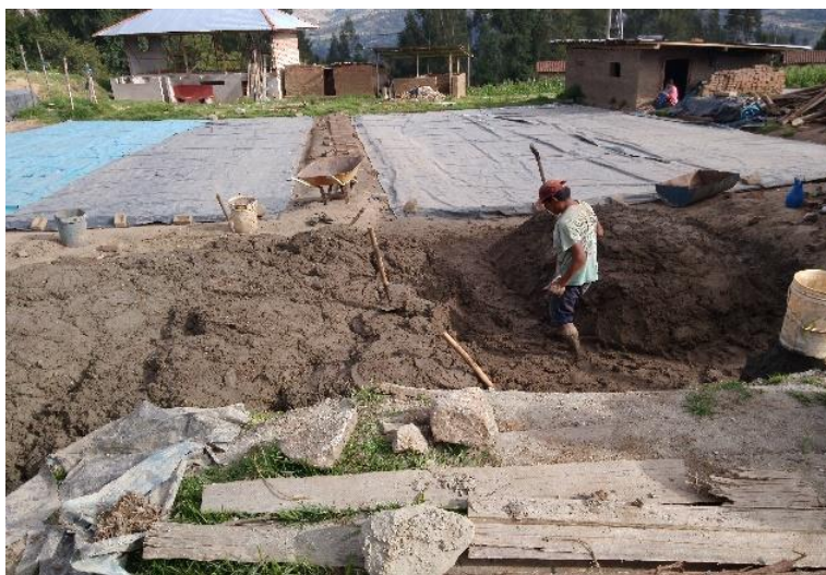
Fotografía N° 5.3: proceso de Amasado o mezcla de arena fina, arena gruesa, y arcilla.
