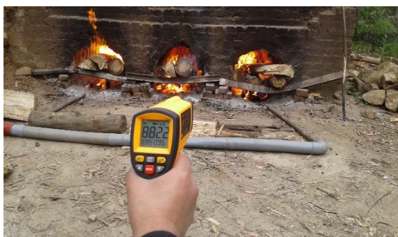
COCCIÓN DE LADRILLOS CON VENTILADOR. CONTROL DE TEMPERATURA CON TERMÓMETRO DIGITAL LASER
