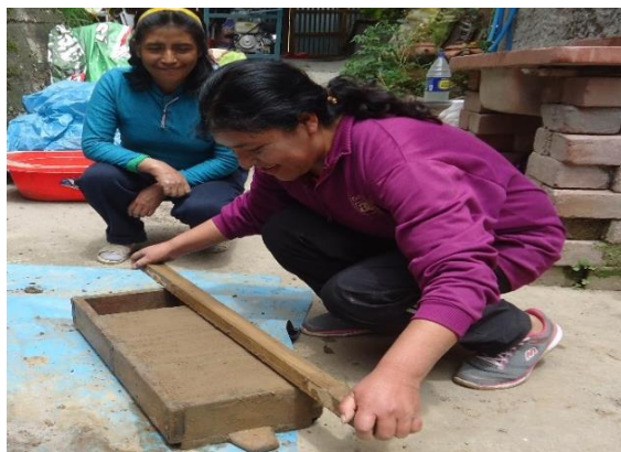
PARTE EXCEDENTE DE LA MEZCLA ELIMINANDO CON TROZO DE MADERA
