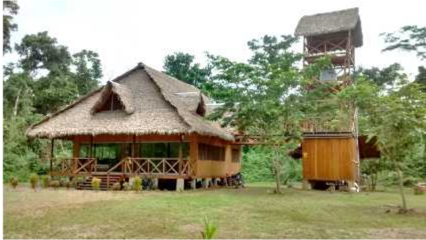
Casas con arquitectura moderna tipo palafito zona baja (condominio Tambo pata fuente propia)
