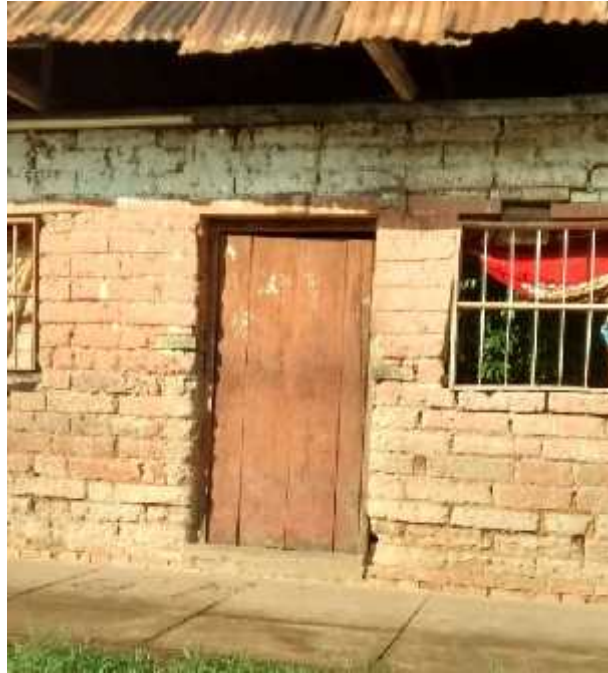
Construcción de adobe en Puerto Maldonado (Jr. Cusco 1ra cuadra Fuente propia)
