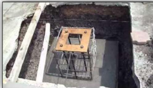
*Fig. 43 Anclaje para Columna de Acero*
