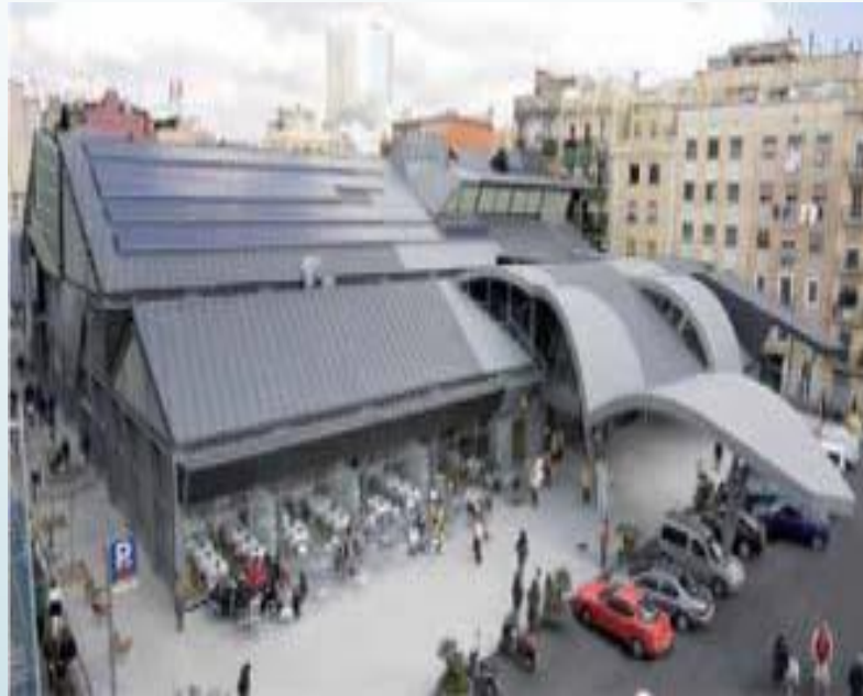
Proyecto N°03: Mercado Tirso de Molina. Arquitectos: Iglesias Prat Arquitectos Ubicación: Santiago, Chile. Año: 2010 Superficie construida: 8 200m 2
