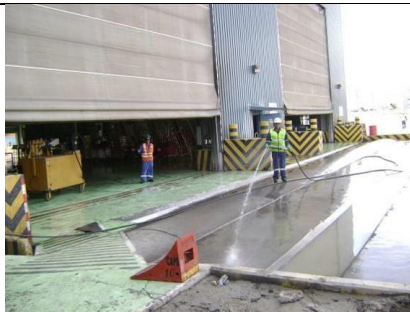
Limpieza de pisos de las áreas con un a solución de Actio (detergente: 50% Agua y 50% Reactivo), se utiliza un aproximado de 1 cilindro (55gal./)mes
