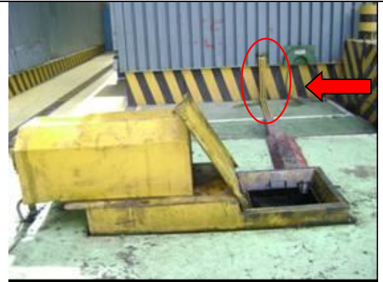
Vista de la Poza Separadora de Aceite Usado que luego se convertirá en Trampa de Grasas y la conexión con tuberías del área de Maestranza
