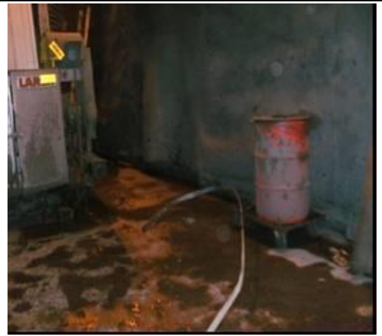
Contenedores implementados para el almacenaje de residuos inflamables (ROJO)
