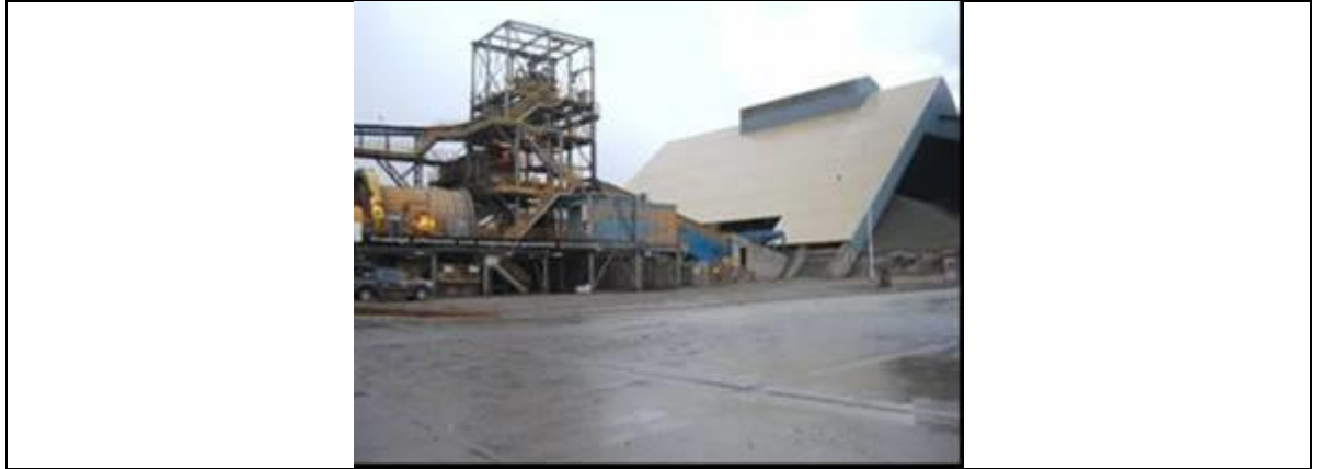
Vista de la parte frontal de la planta de Sulfuros
