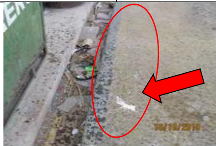
Vista de vidrios rotos encontrados al pie del contenedor de residuos domésticos.
