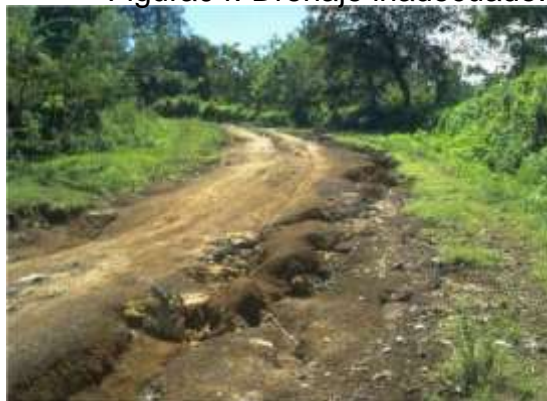
Figura04: Drenaje inadecuado.
