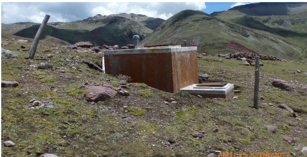
Imagen 23: Estado actual del reservorio 1, ubicado en el sector de Paccobamba (Sin protección)
