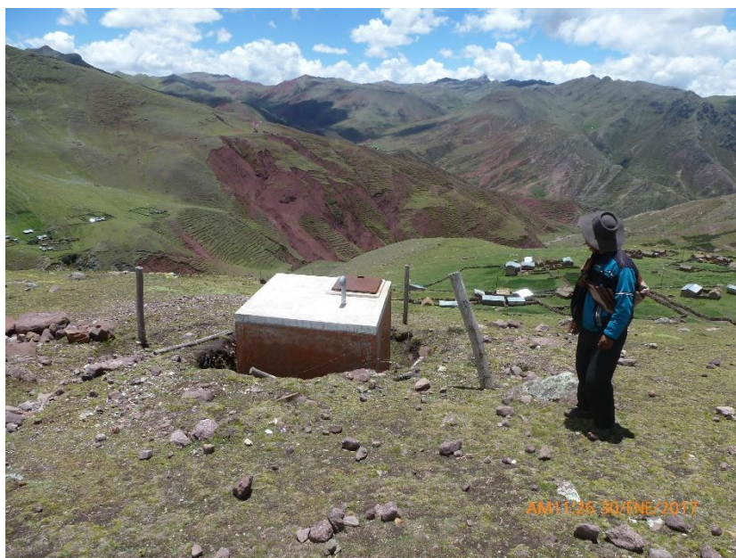
Imagen 44: Reservorio existente N° 1, en el sector de Paccobamba.
