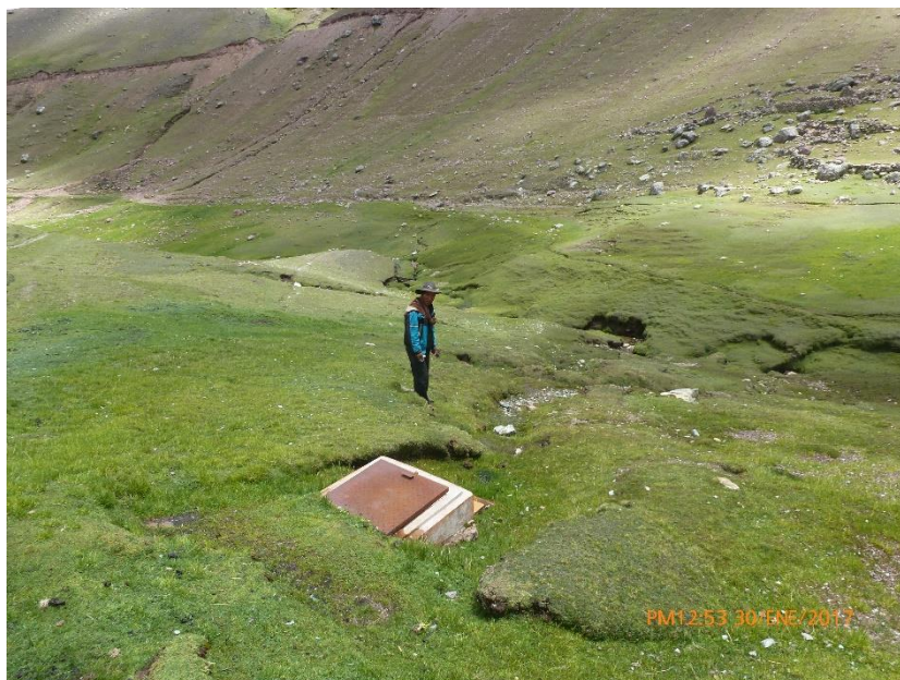
Imagen 40: Captación existente N° 2 en el sector de Paccobamba, barrio Huaccuyo
