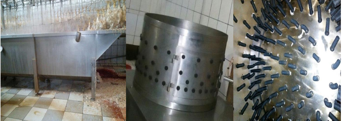
CF. 14 y 12. Escaldado y Desplume: Tanques de Acero, Automáticos
