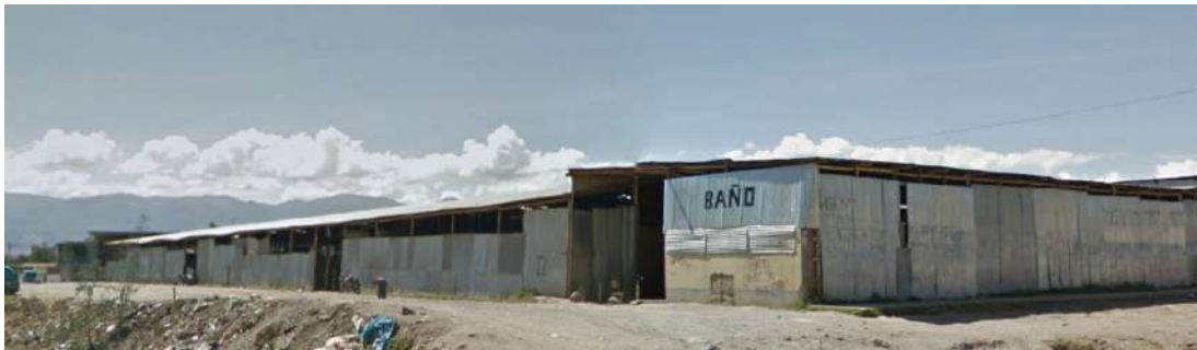
IMAGEN 08: Vista de servicios higiénicos
