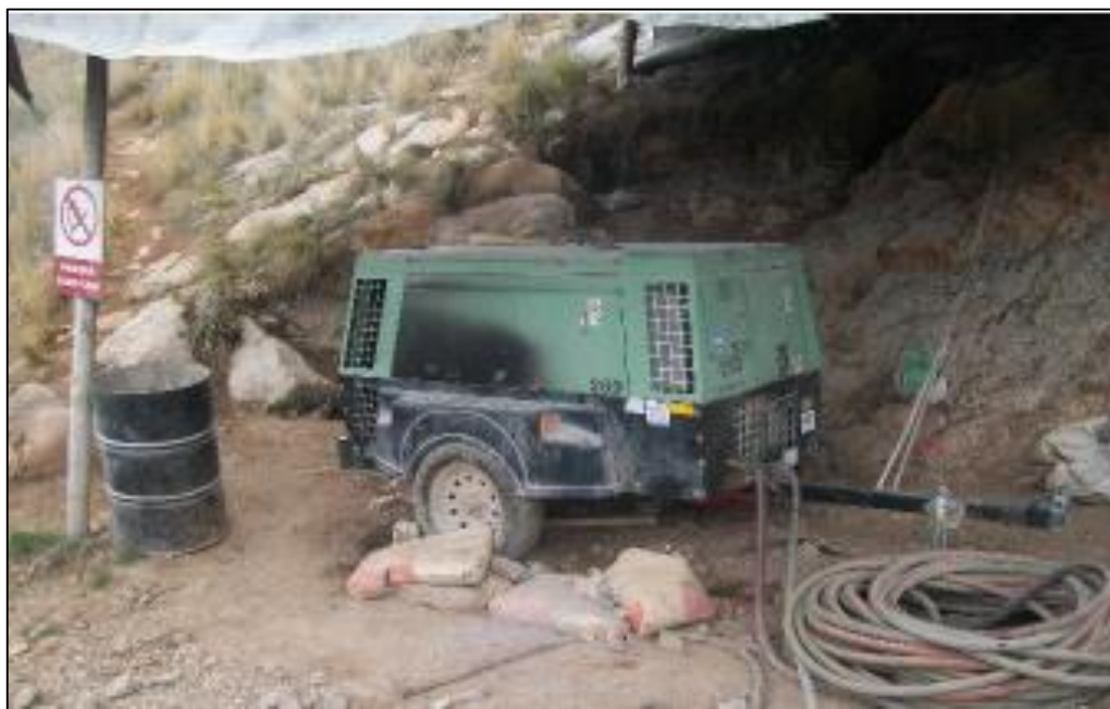
Maquinaria para realizar la perforacion
