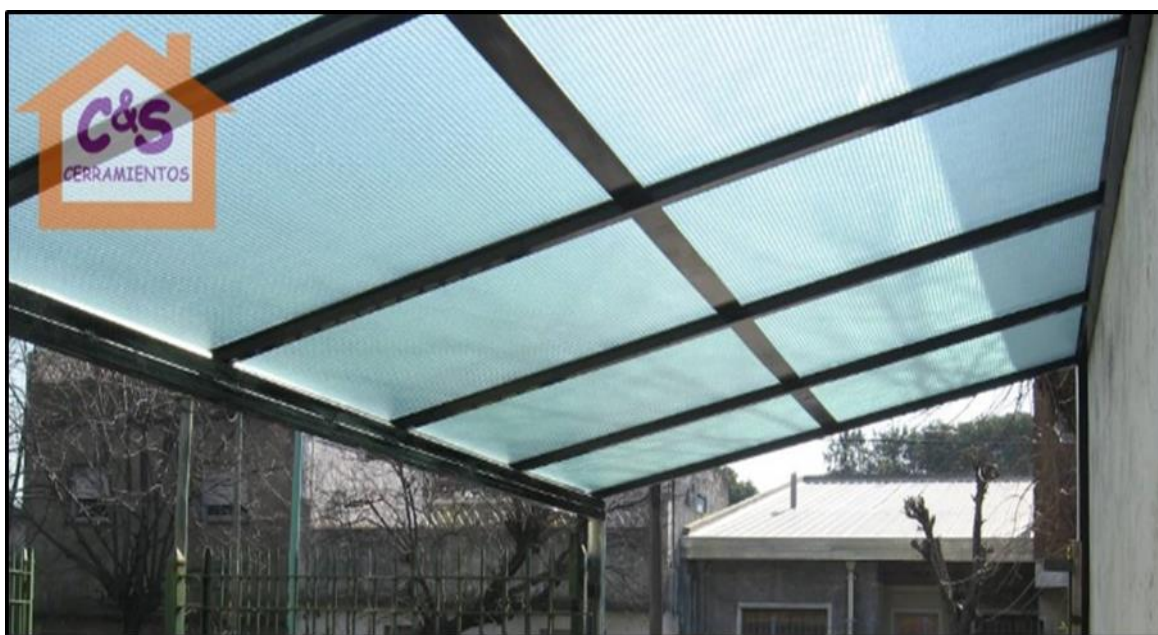
FOTOGRAFIA 5: TECHO DE POLICARBONATO ALVEOLAR
