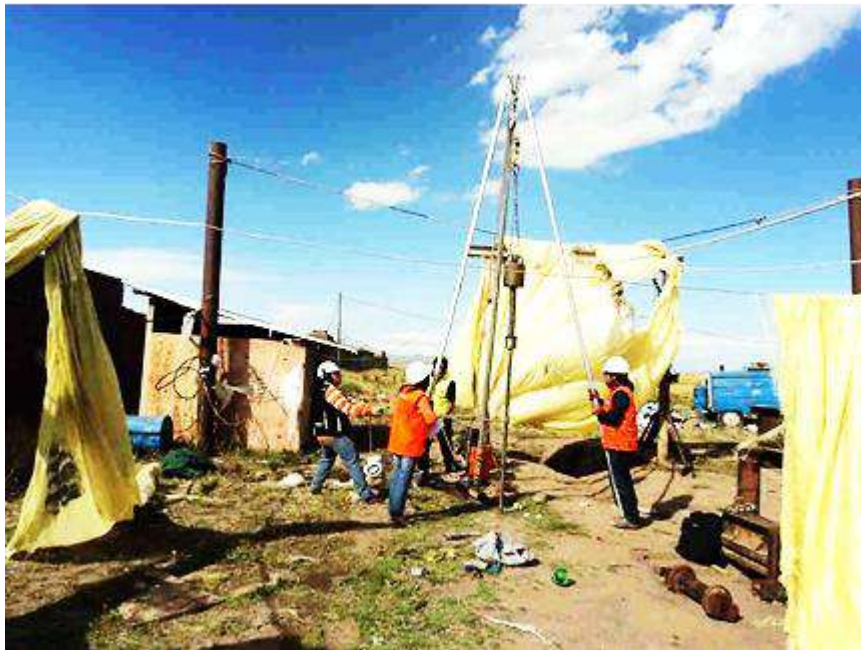
Figura n° 7 Ensayo de Penetración Estándar (SPT)
