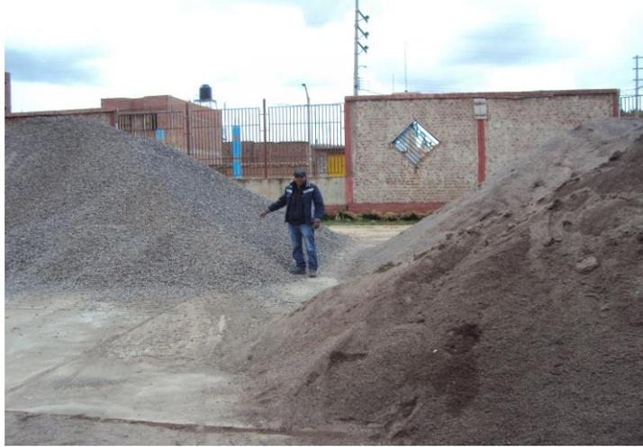
**IMAGEN N° 1:** Piedra chancada de ¾", arena chancada de 3/8" y arena natural almacenados en la planta de procesamiento de Cabanillas.
