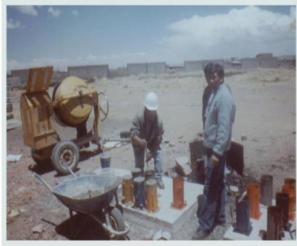
**Figura 17.** Compactación de concreto con una varilla lisa de 5/8"
