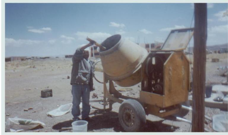
**IMAGEN N°5:** Mezclado del concreto y adición de aditivo
