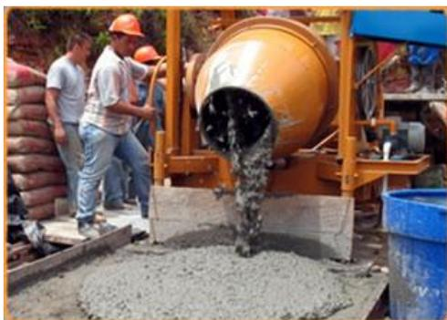
**Figura 2.** Concreto en estado fresco
