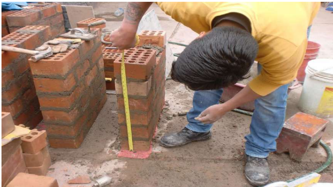
FOTO N°59 y 60: Control de las juntas en elaboración del murete
