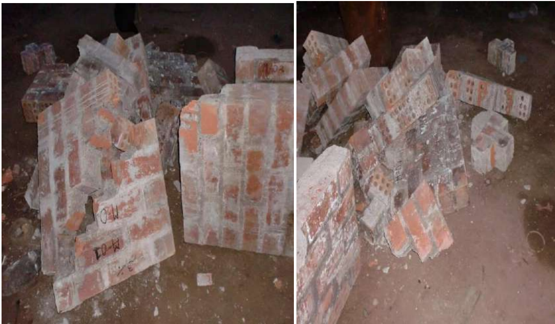
Foto N° 57 y 58: Muestras después del ensayo de corte diagonal.
