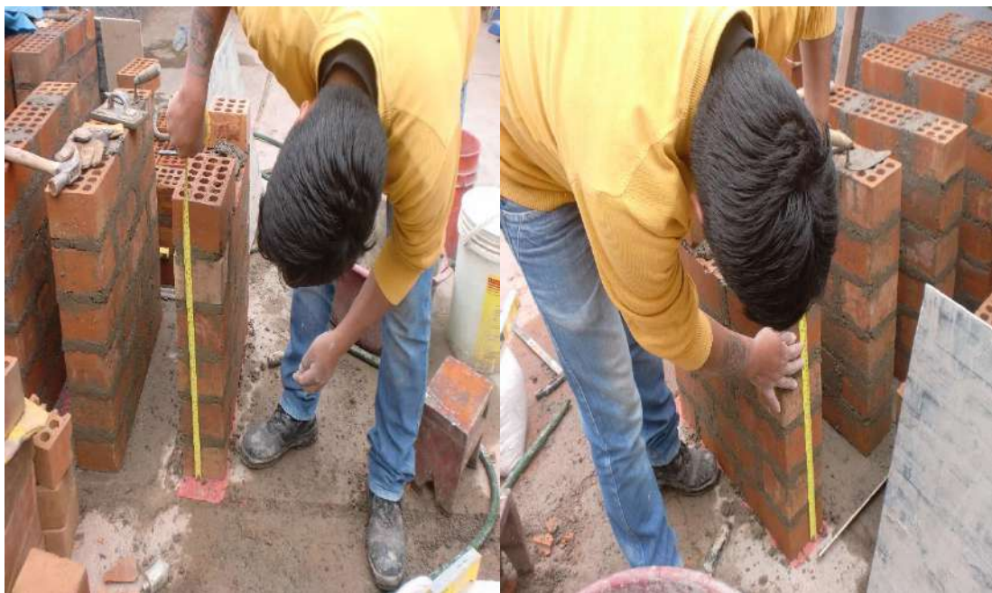
Foto N° 46: Control de espesor de junta en elaboración de muretes
