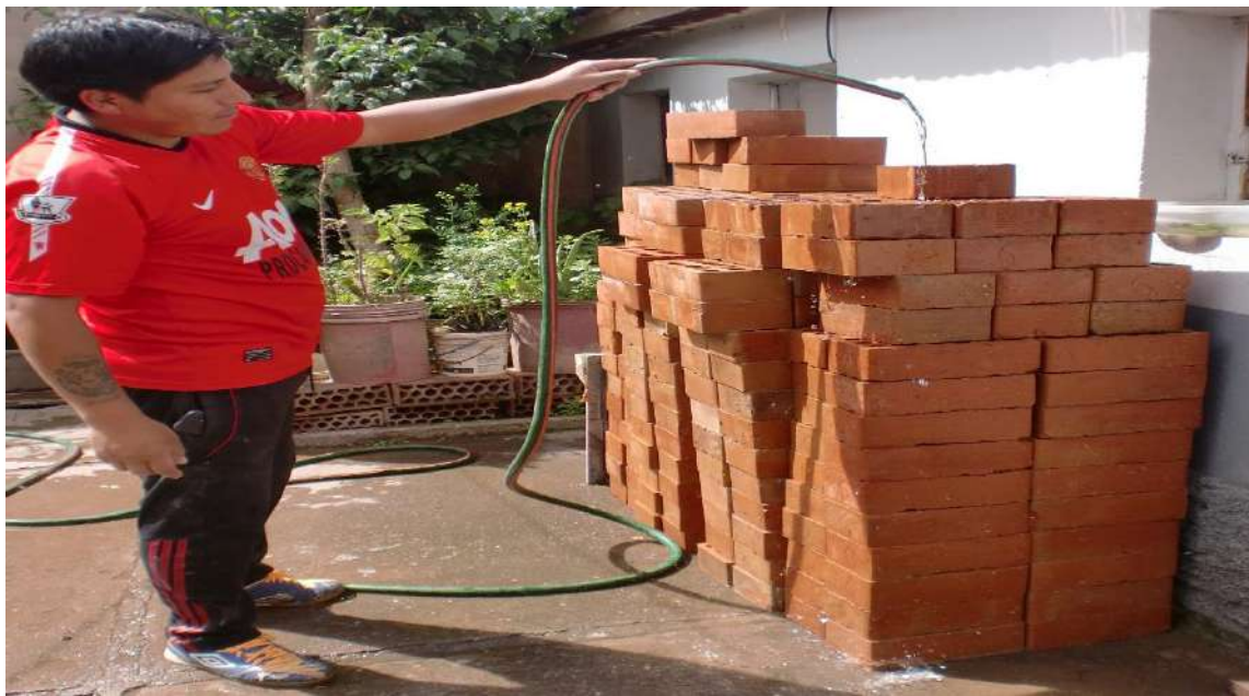
Foto N° 34: Regado de las unidades de albañilería de la ladrillera “BELLOTA”
