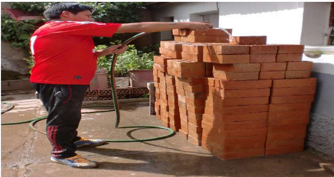
Foto N° 42: Regado de las unidades de albañilería de la ladrillera “BELLOTA”
