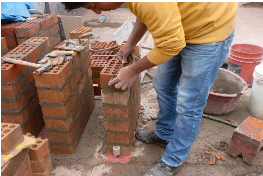
Foto N° 44: aplomado de la verticalidad del murete.
