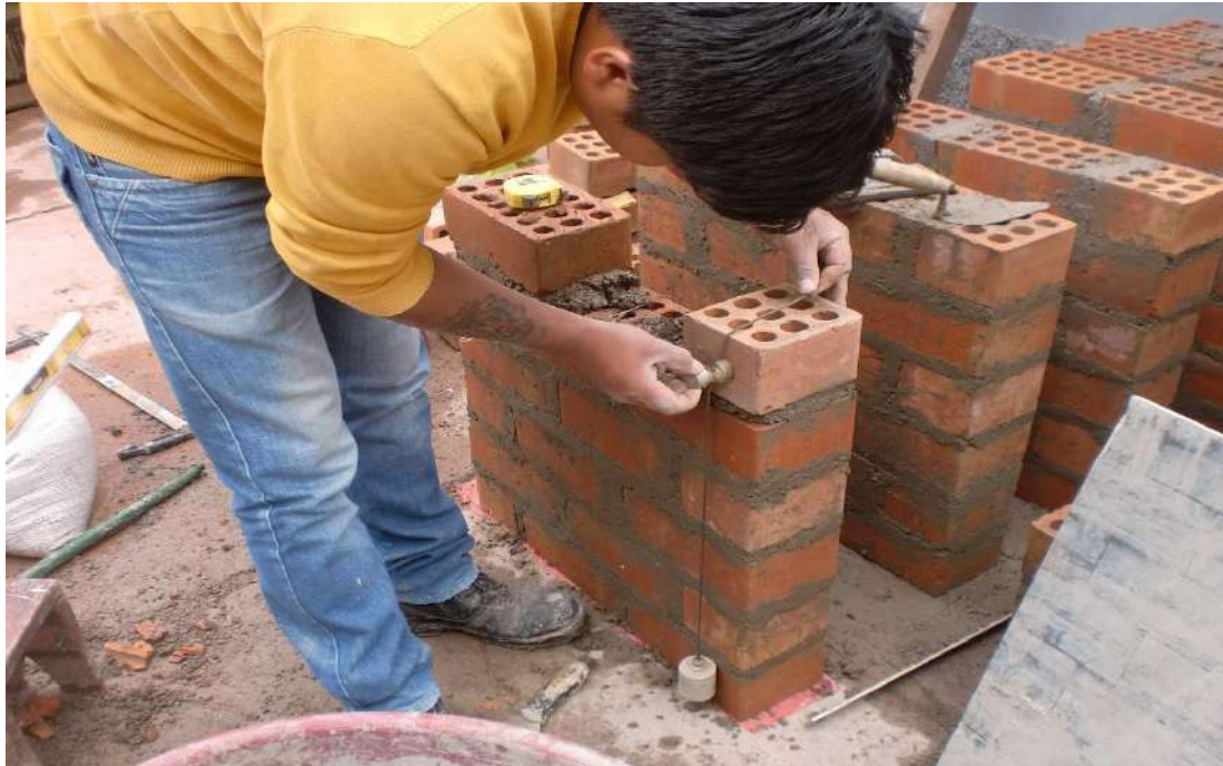
Foto N° 45: aplomado de la verticalidad del murete.
