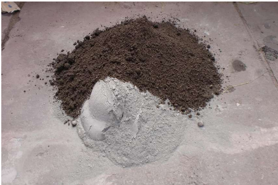
Foto N° 36: Dosificación por volumen del cemento
