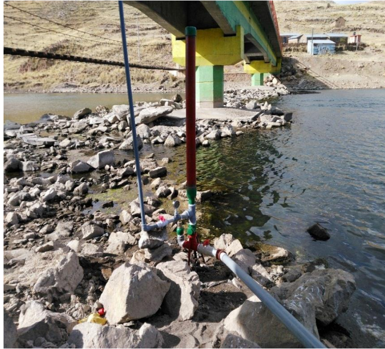
Foto 5. Instalación de la bomba de ariete en el río Pucará
