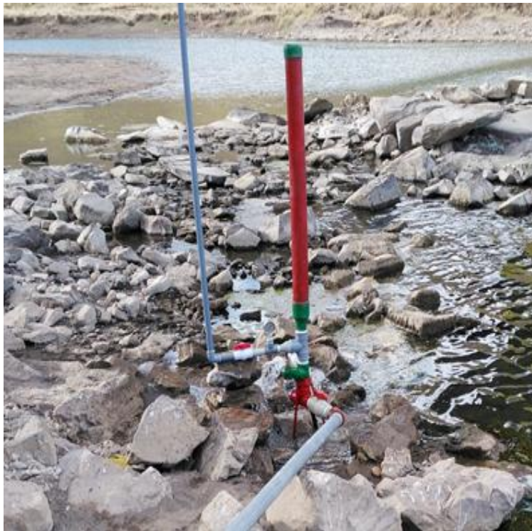
Foto 10. Finalización del sistema de bombeo
