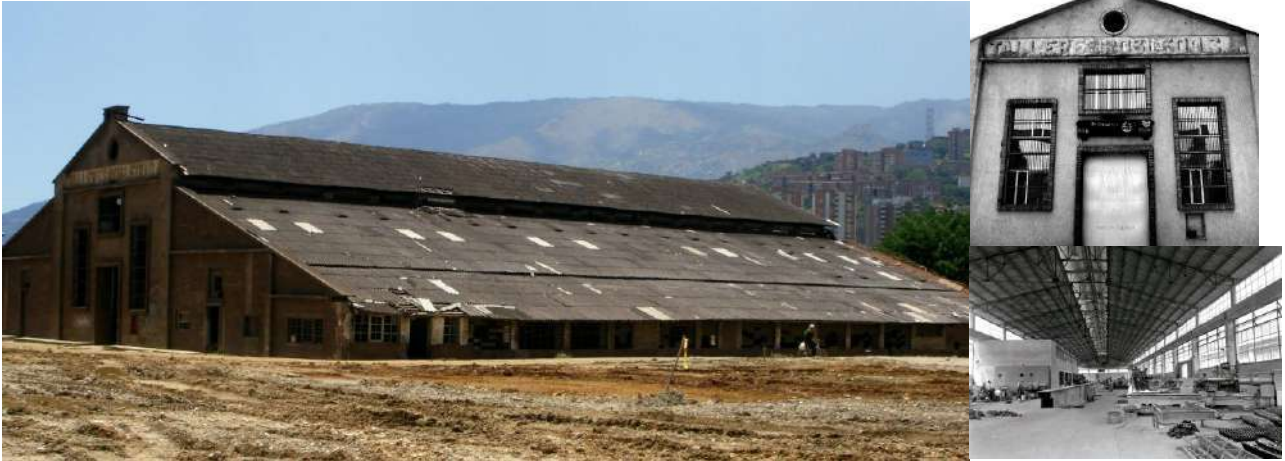
Imagen 16. Edificio original de los talleres Robledo
