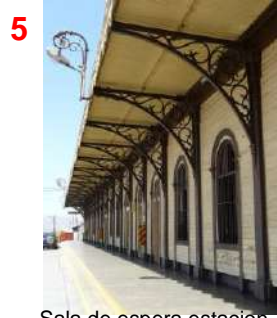
Sala de espera estación
