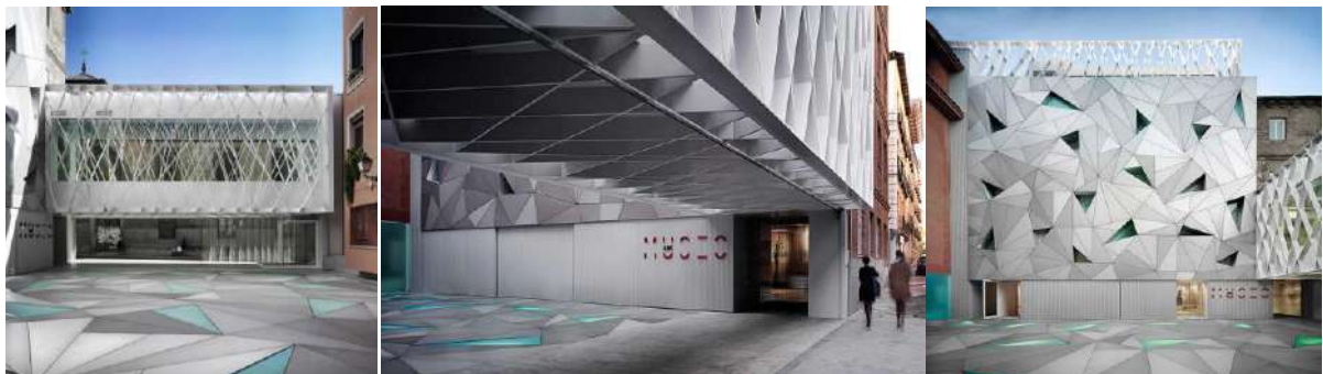
Imagen 29. Expresivo suelo de vidrio se convierte en el techo del sótano del museo, regando al interior la luz natural
