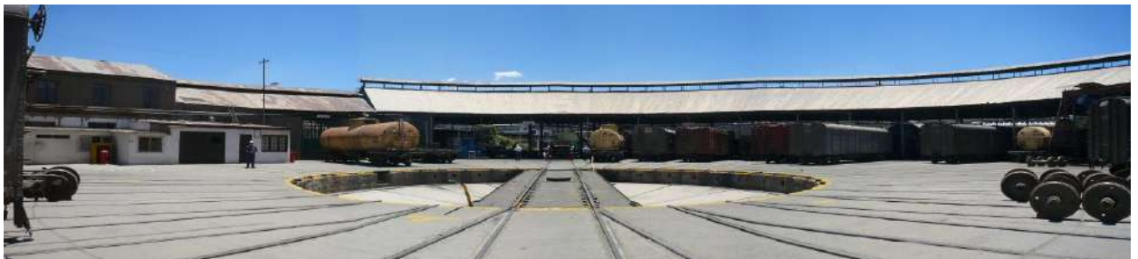
Imagen 8. Levantamiento fotográfico de los Interiores de la Estación del Ferrocarril y la casa de máquinas
