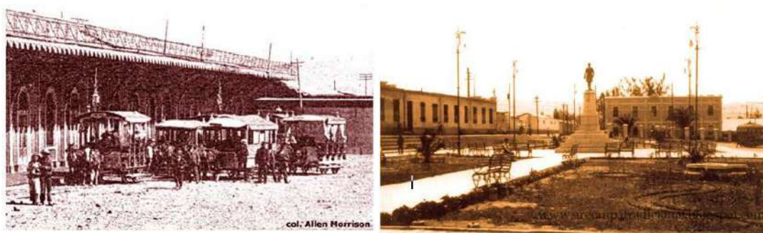
Imagen 52. Estación del ferrocarril
