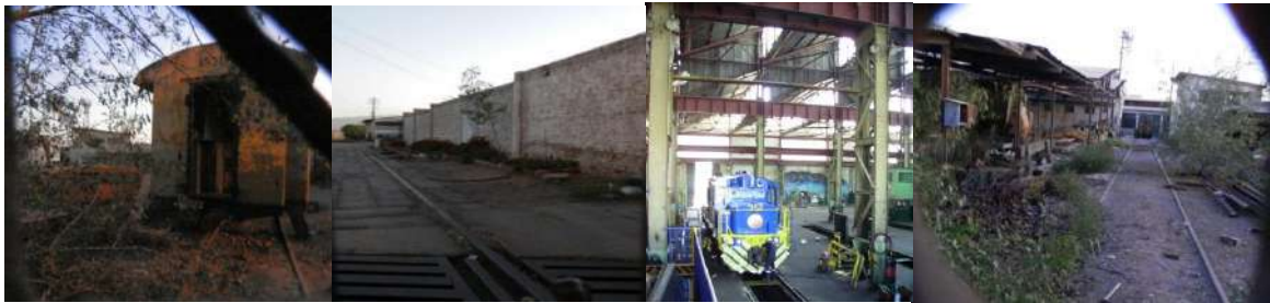
Imagen 9. Levantamiento fotográfico de los Interiores de la estación del ferrocarril, vías y obras
