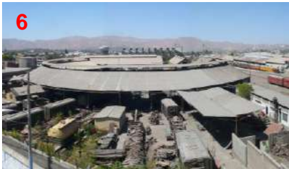
Casa de maquinas
