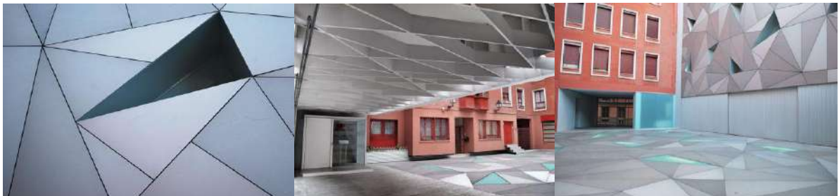
Imagen 31. Los arquitectos han aprovechado las virtudes de la edificación histórica
