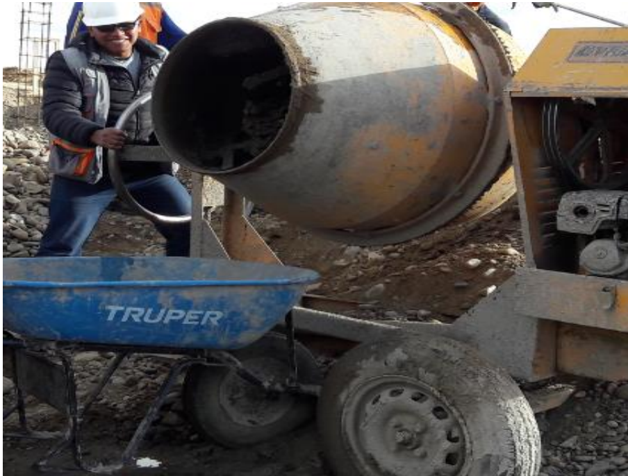
Figura N° 11 Preparación de mezcla en mezcladora trompo Fuente Propia
