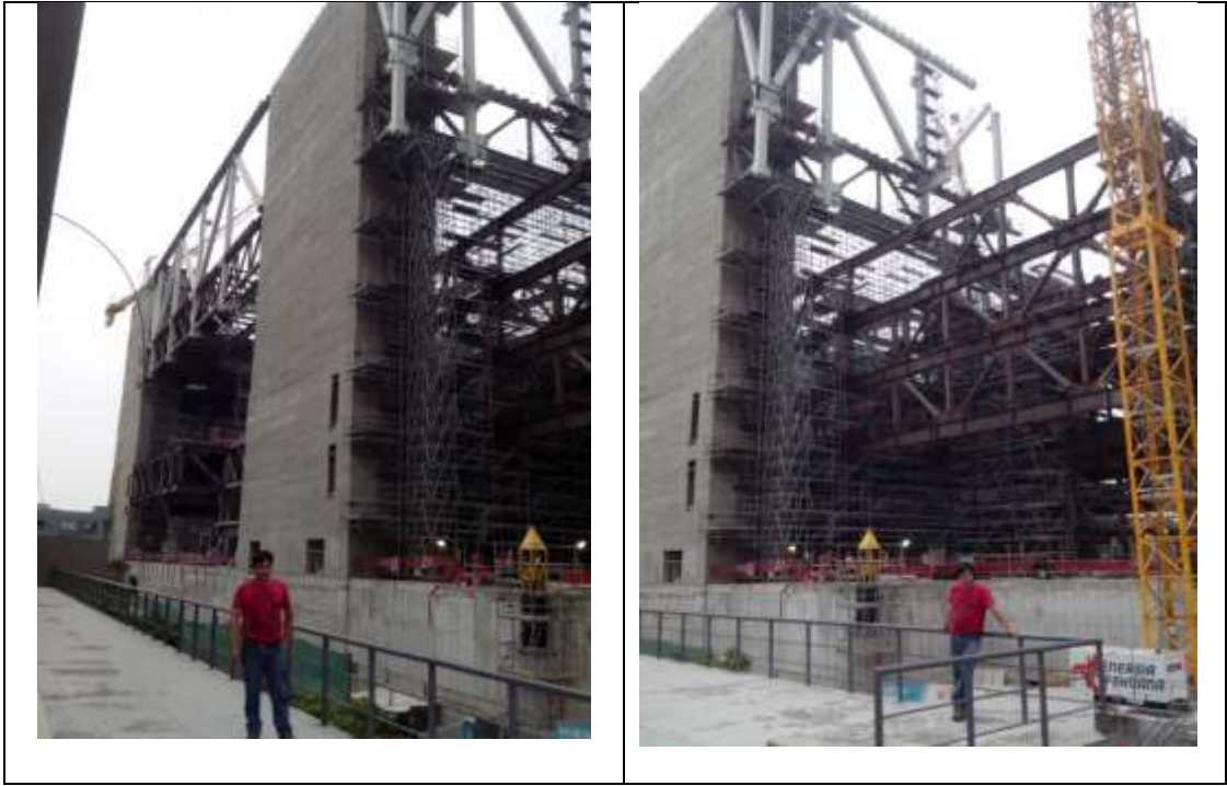
(Figura 19) Edificio de Banco de la Nación - Lima Fuente: propio
