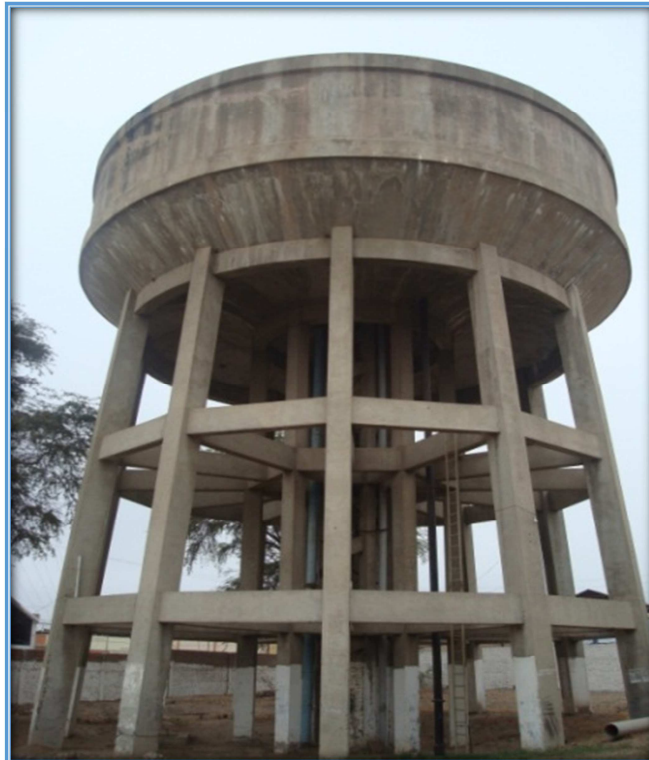
Vista elevación del Reservorio Grau
