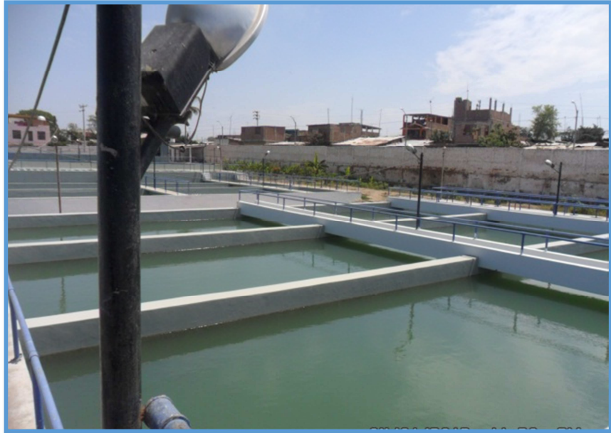
Imagen N° 29 Vista fotográfica sedimentadores
