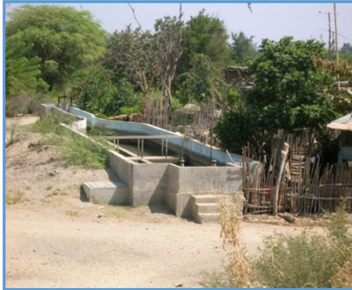
Imagen N° 22 Vista del Desarenador en Operación
