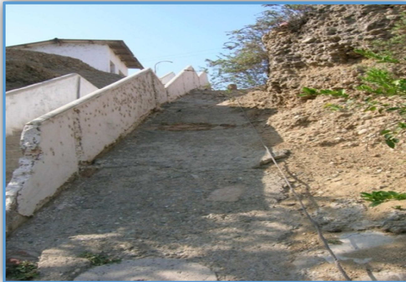
Imagen N° 25 Vista fotográfica de los exteriores de la captación de emergencia.
