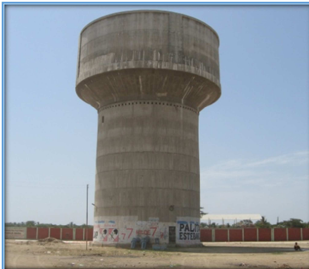
Vista en elevación del Reservorio Bellavista
