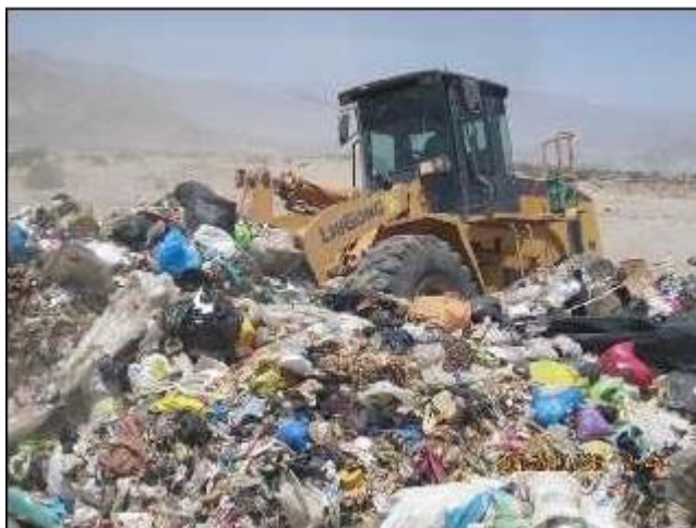
ILUSTRACIÓN N° 5 Sellado de Residuos Sólidos
