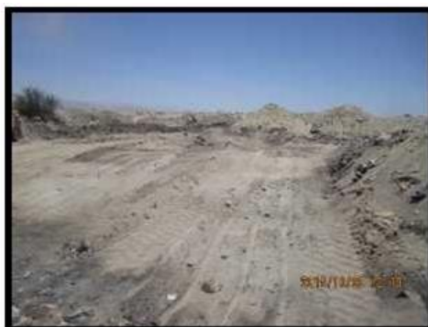
ILUSTRACIÓN N° 6 Sellado de Residuos Sólidos
