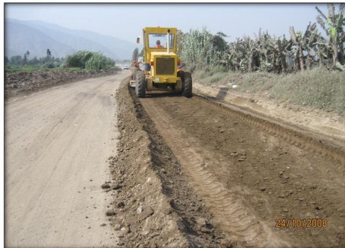
Figura 2.3. Perfilado de terreno, ensanche de la carretera.
