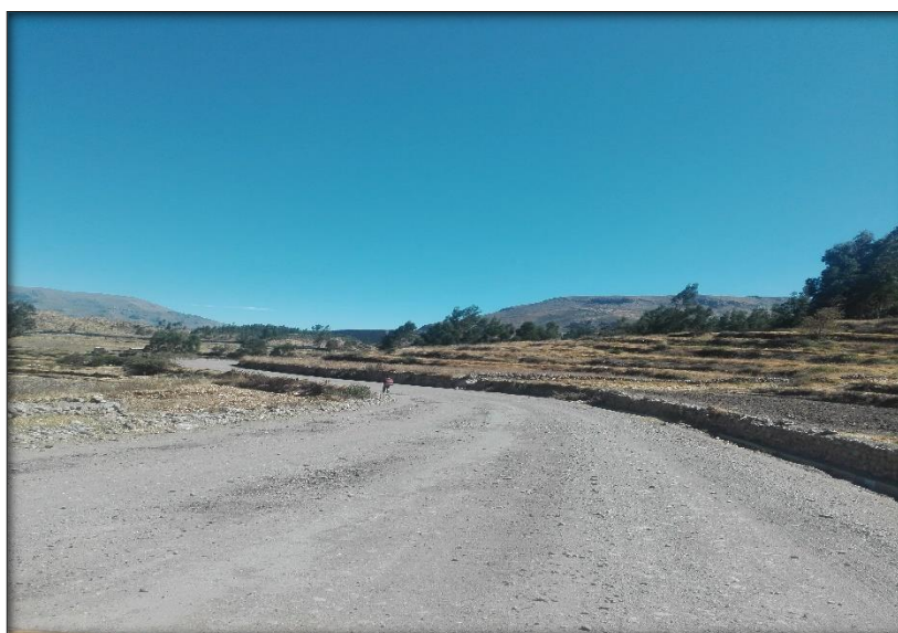
Figura 3.9. Tramo inicial Ichupampa-Lari
