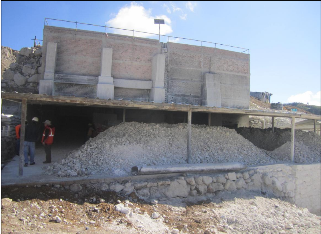
Figura 13: Vista frontal de los hornos. Fuente: Elaboración propia, 2017.
