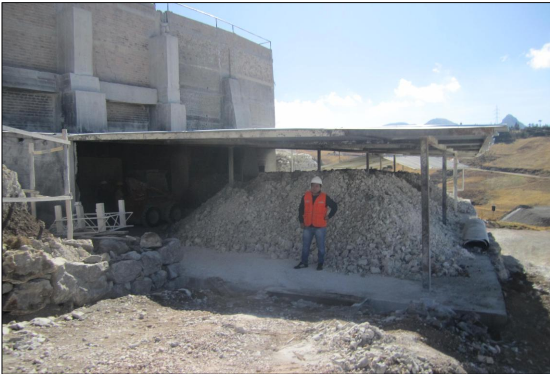
Figura 14: Almacén de cal viva granada. Fuente: Elaboración propia, 2017.
