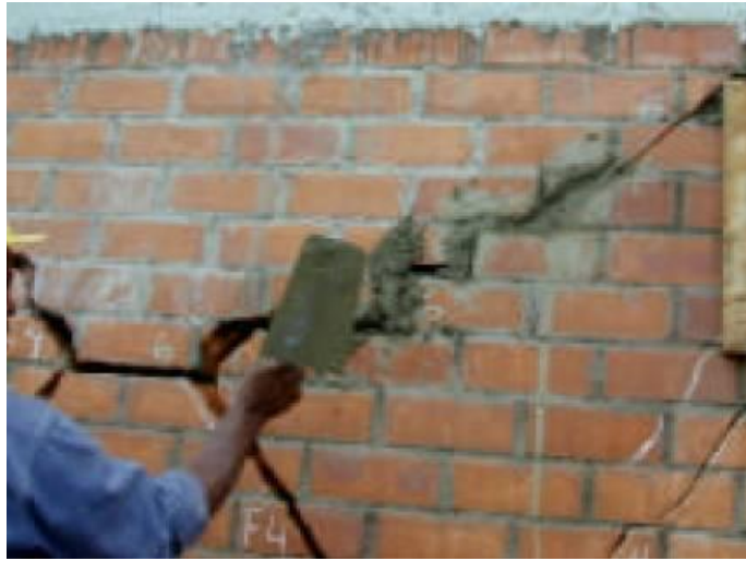
FIGURA N° 28. REPARACIÓN DE GRIETAS GRUESAS
