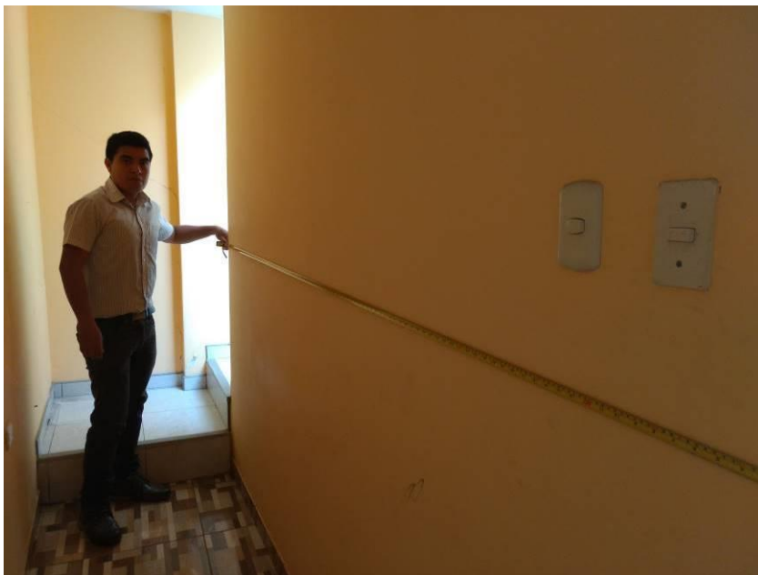
FIGURA N° 34. LONGITUD DE MURO.
