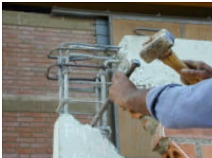
FIGURA N° 29. PICADO DEL NUDO VIGA COLUMNA
