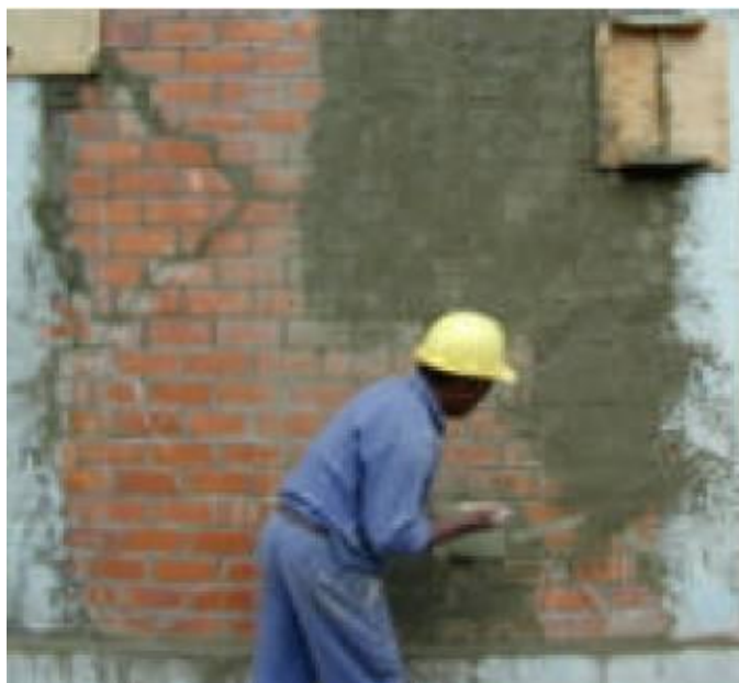
FIGURA N° 30. PAÑETEO DEL MURO
