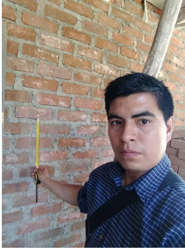
FIGURA N° 38. MEDICIÓN DE JUNTA DE LADRILLOS
