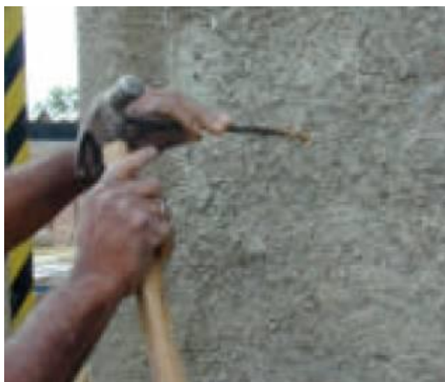
FIGURA N° 31. PERFORACIÓN DEL MURO
