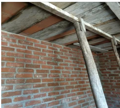
FIGURA N° 25. UNIÓN MURO-TECHO NO MONOLÍTICO.
