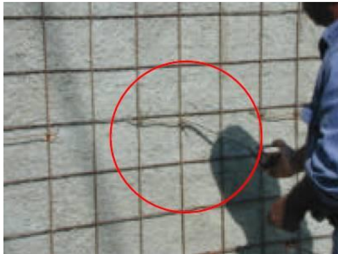
FIGURA N° 32. FIJADO DE LA MALLA ELECTROSOLDADA
