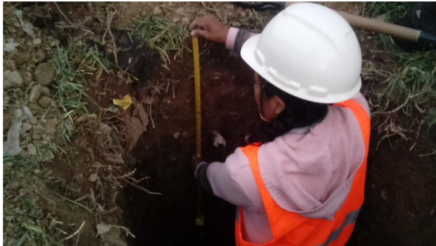
Figura 1: Excavación de las calicatas
