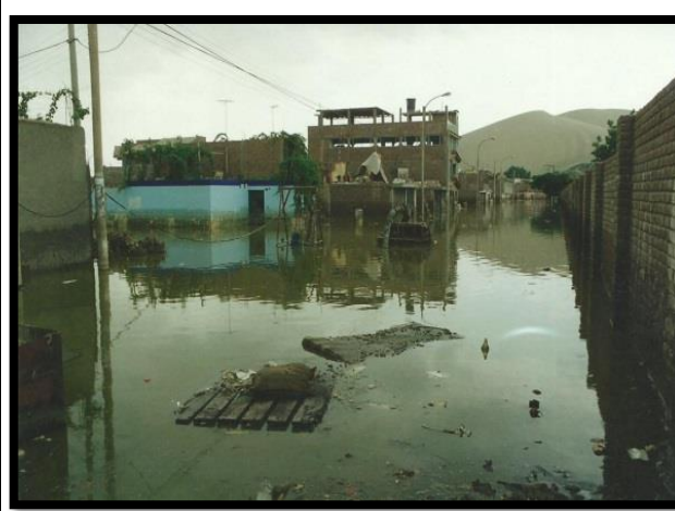
Calle Tacna, después de la inundación del año 1998.
