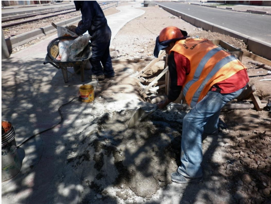
PROCESO DE BATIDO DEL CONCRETO DESTINADO PARA TAPA DE POSO
