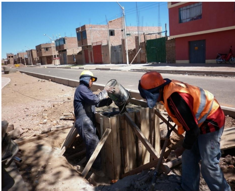
COLOCADO Y ACABADO DE TAPA DE POSO
