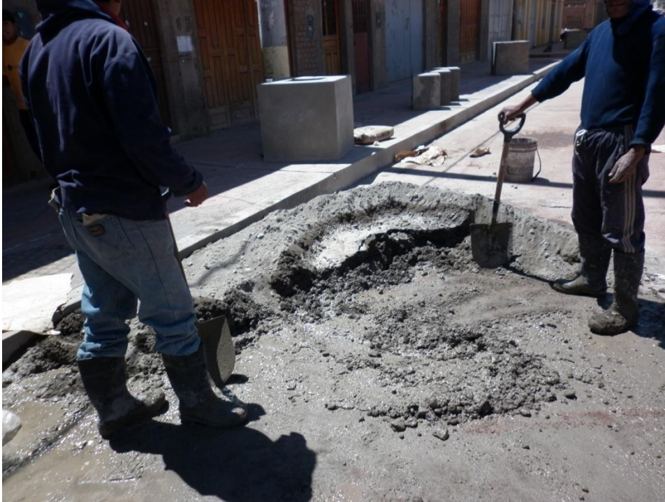
PROCESO DE MEZCLADO ARTESANAL DEL CONCRETO DESTINADO PARA VIGAS DE CIMENTACION
