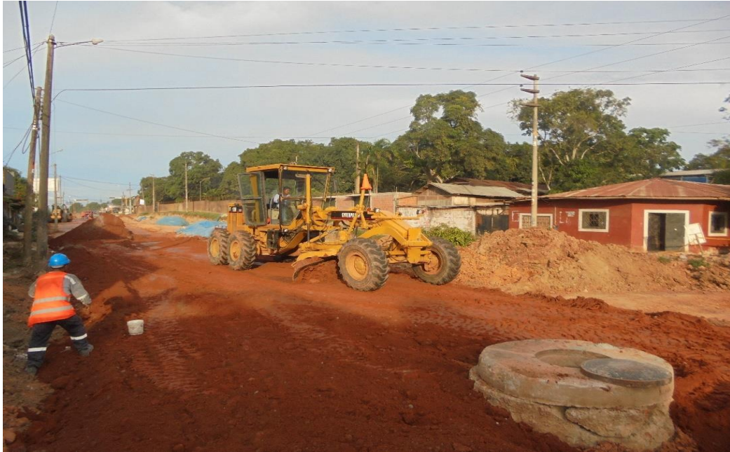
Figura N° 29: Riego y compactación de la capa de base granular.
