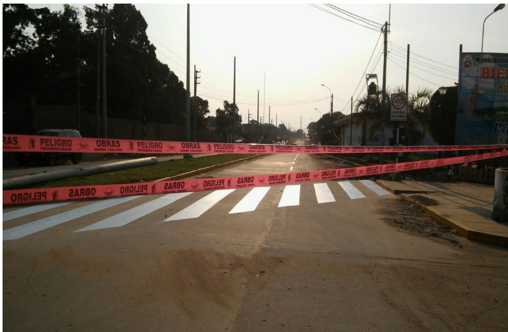
Figura N° 44: Pintando la señalización del pavimento rígido.
