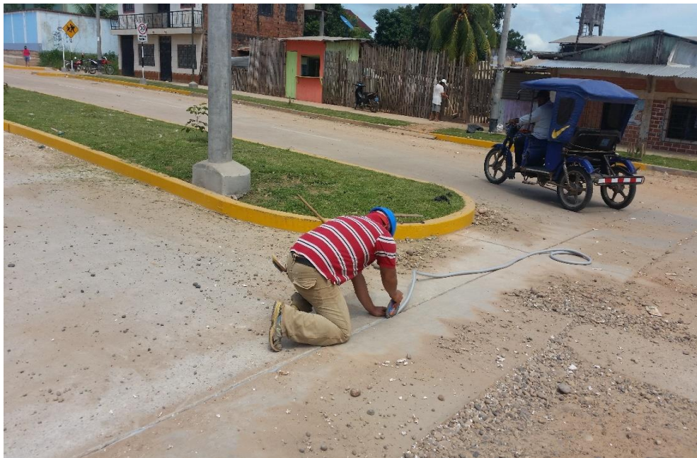
Figura N° 42: Limpieza y sellado de juntas de contracción y dilatación.
