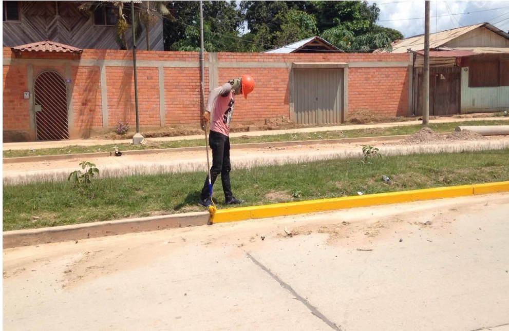
Figura N° 43: Pintando la señalización del pavimento rígido.
