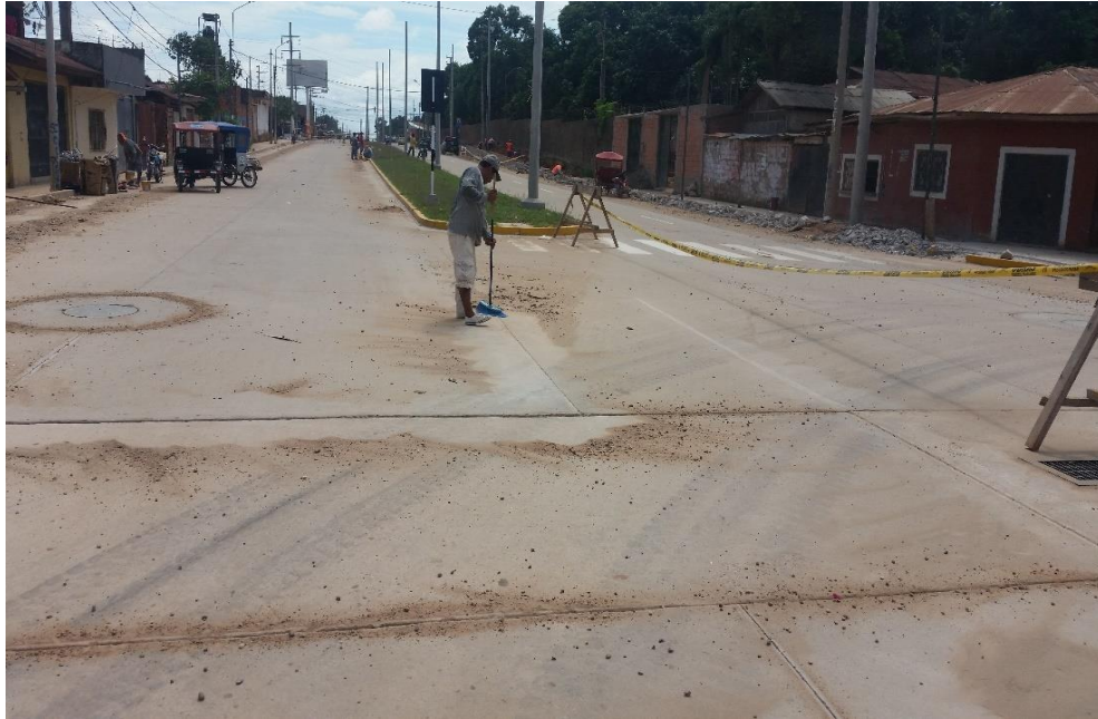
Figura N° 41: Limpieza y sellado de juntas de contracción y dilatación.
