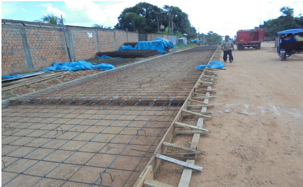
Figura N° 34: Encofrado y enmallado de losas cortas en los pavimentos rígidos.
