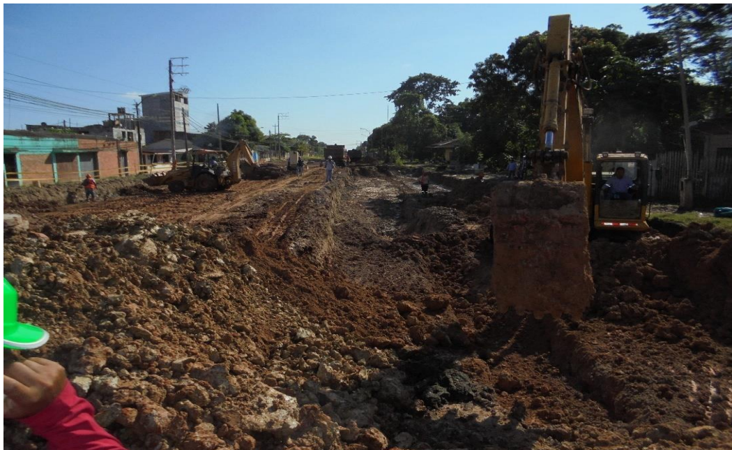
Figura N° 26: Excavación del terreno para cimentación.
