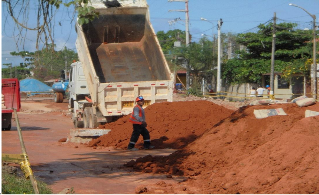
Figura N° 27: Preparación del suelo para amentar la capacidad portante del terreno
