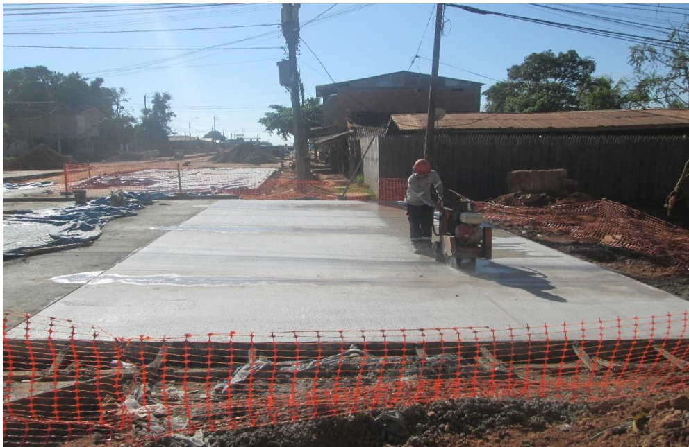
Figura N° 40: Corte con maquinaria en las juntas de contracción de las losas cortas de los pavimentos rígidos.
