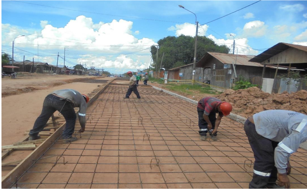
Figura N° 33: Encofrado y enmallado de losas cortas en los pavimentos rígidos.
