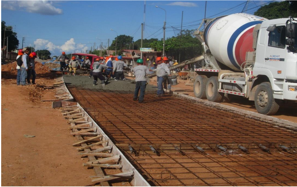
Figura N° 35: Vaciado de concreto en las losas cortas de los pavimentos rígidos
