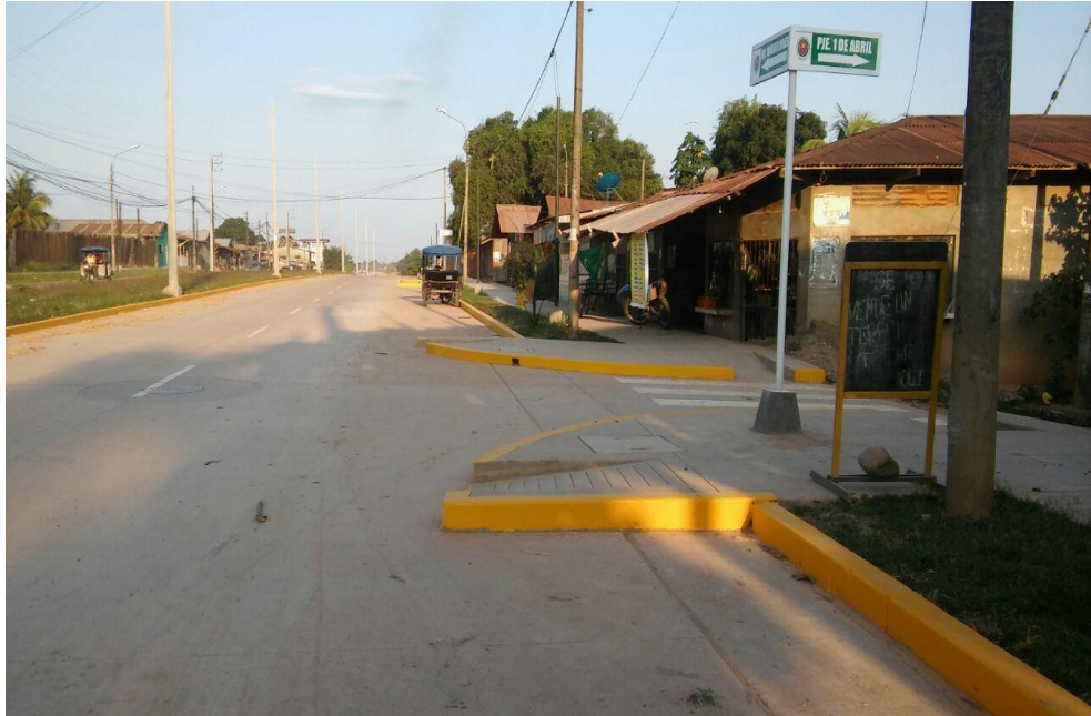
Figura N° 45: Limpieza final de la obra.
