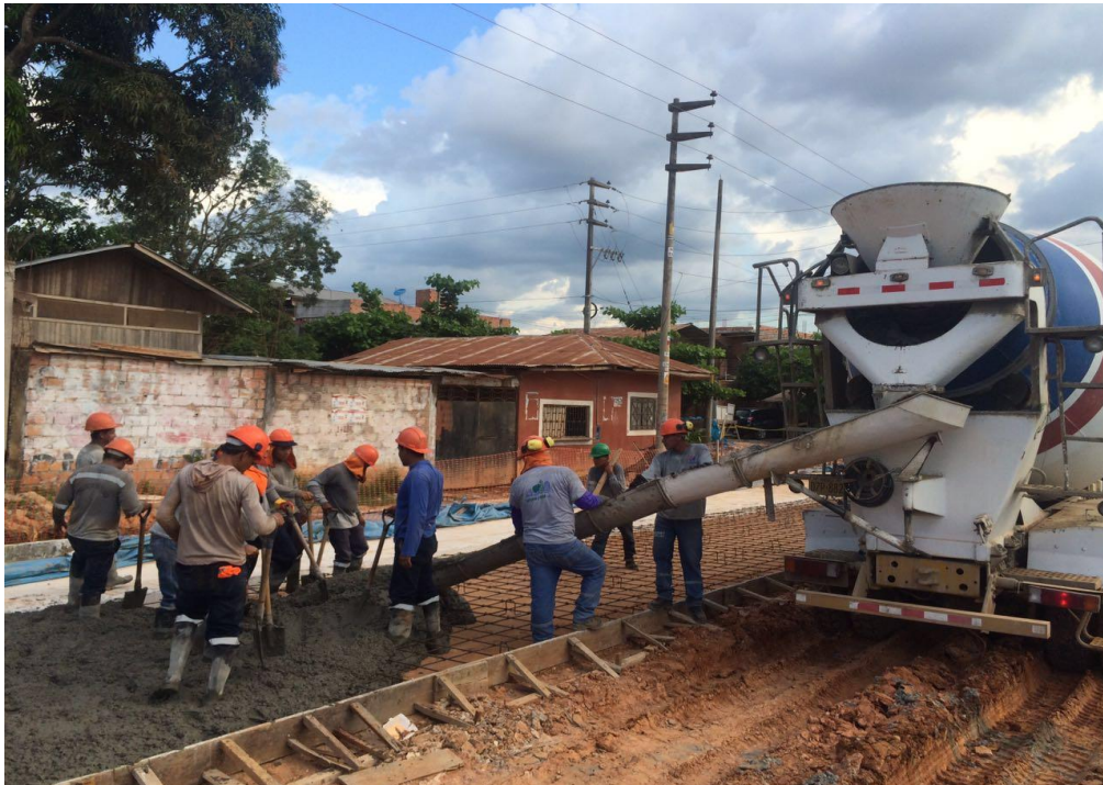
Figura N° 36: Vaciado de concreto en las losas cortas de los pavimentos rígidos
