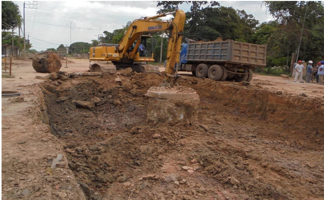
Figura N° 25: Excavación del terreno natural con fines de cimentación
