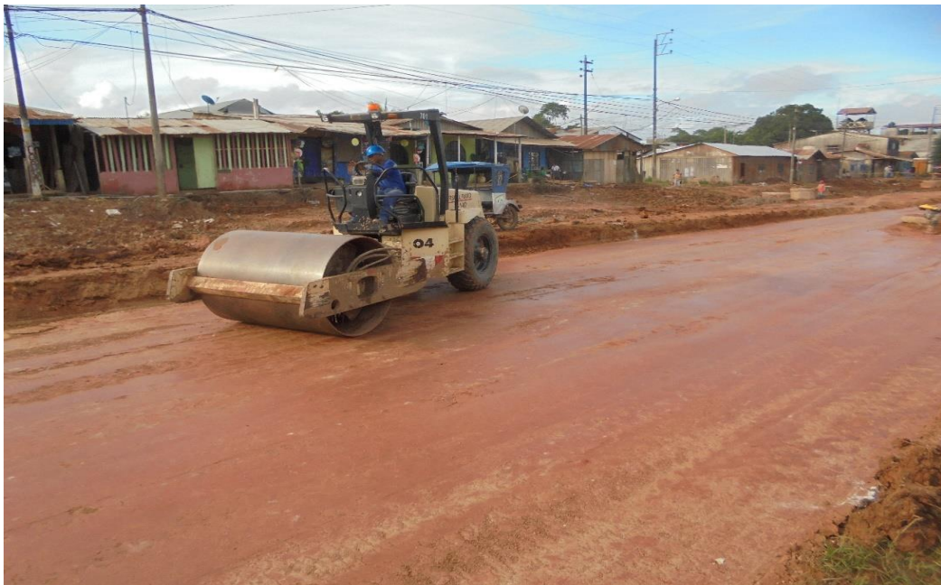
Figura N° 30: Riego y compactación de la capa de base granular.
