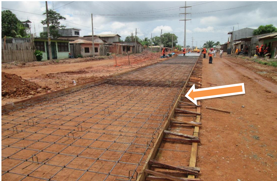
Figura N° 19: Construcción junta longitudinal con formaleta
