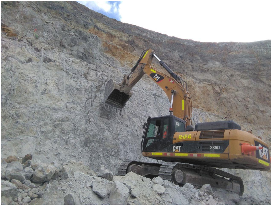
Figura 54: Perfilado de talud
