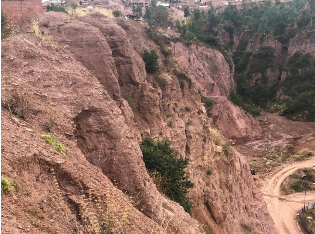
Figura 25: Cárcavas producto de la erosión cuyo agente es el agua de lluvia.
