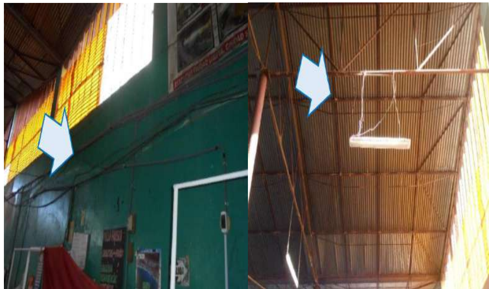
IMAGEN 01: Vista del techo actual e instalaciones eléctricas 1
