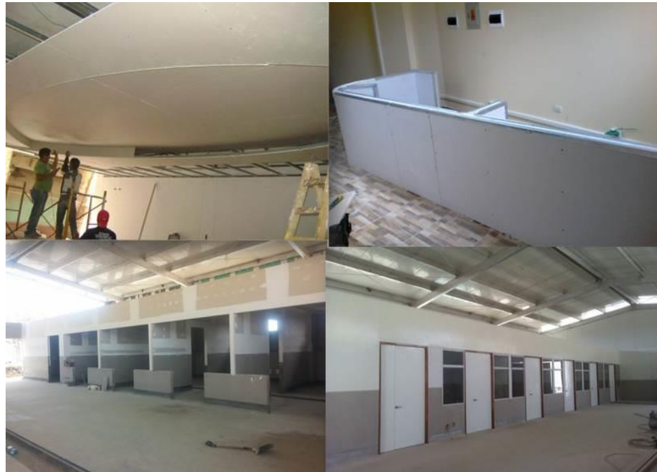
Figura 2. Construcción en seco o drywall Fuente: Elaboración propia, 2016.
