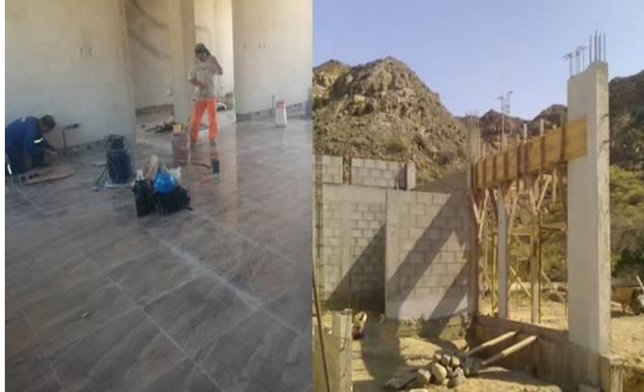
Figura 9. Mantenimiento y labores en obras civiles Fuente: Elaboración propia, 2017.
