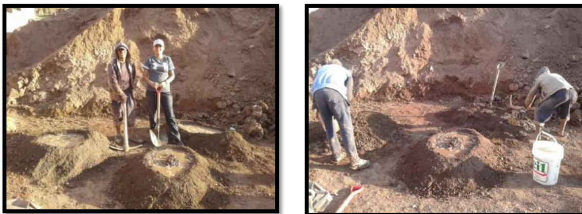
Fig. 5 Preparación de la masa para los adobes mejorados utilizando el suelo del C.P Pallpancay añadiendo arena
