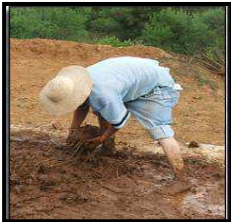
Figure 2.133 Elaboración artesanal de bloques de Adobe (Fuente: Habitación y Desarrollo)
