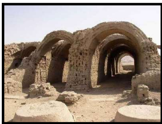
Figure 2.5 Bóvedas Mortuorias de Ramsés II, Egipto (Fuente Zonaforo Meristation)
