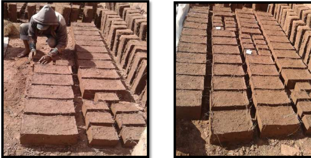
Fig. 8 Elaboración de los Adobes mejorados con distintas dosificaciones de Arena-Suelo
