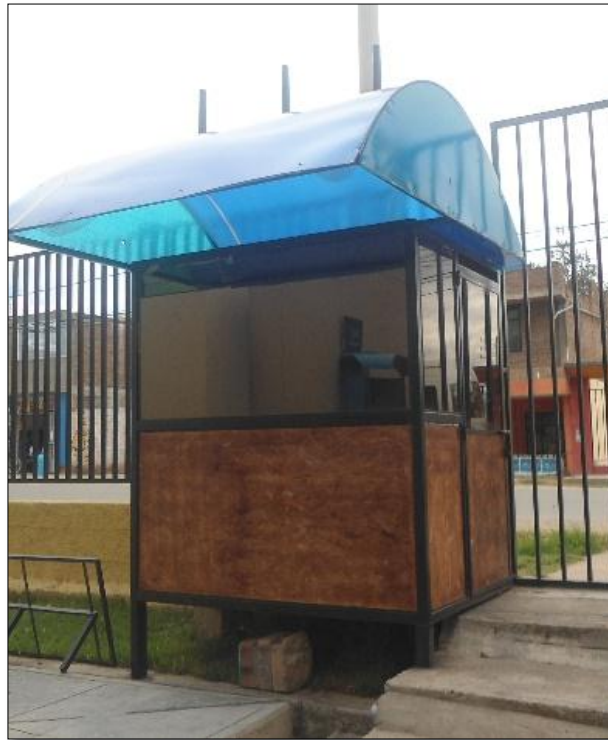
Figura 18: Implementación de los vidrios de la Caseta de Vigilancia
