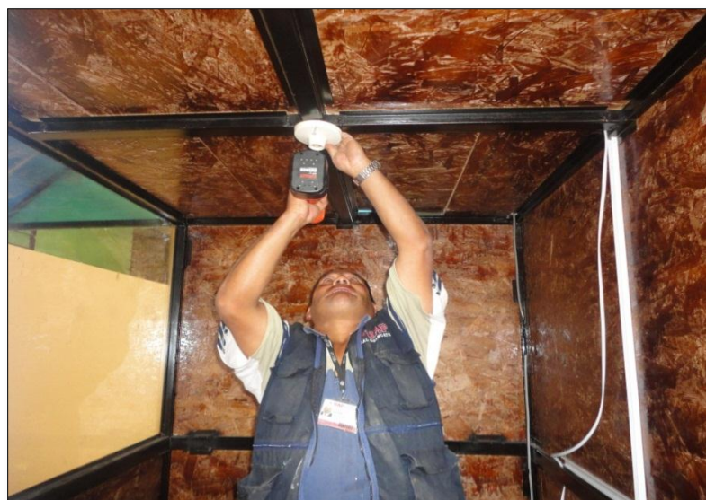
Figura 22: Instalación de luminarias
