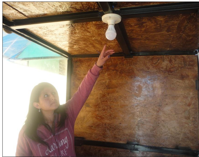
Figura 24: Instalación de luminaria interna
