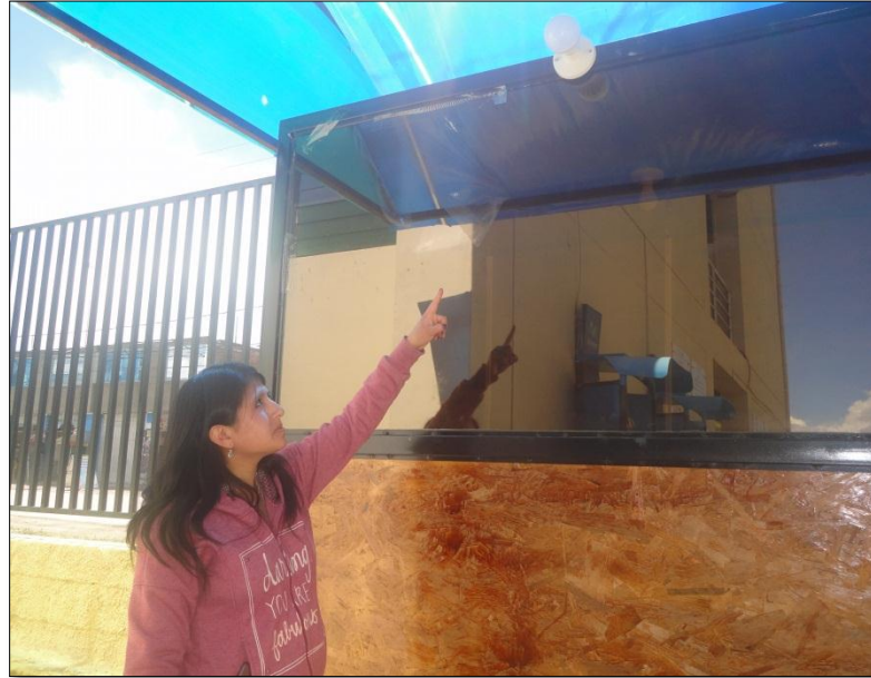
Figura 23: Instalación de luminarias externas
