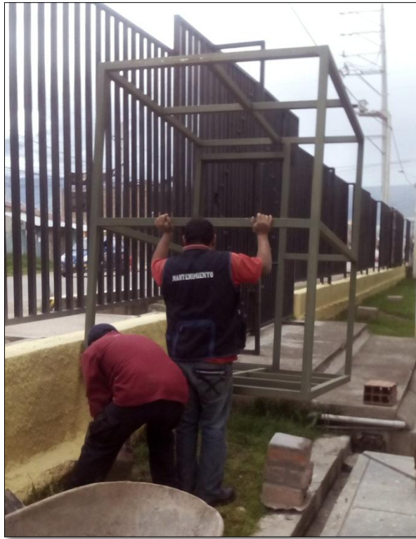
Figura 15: Instalación de la plataforma de la Caseta de Vigilancia
