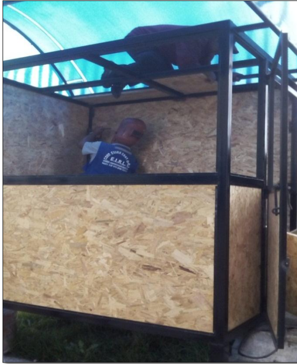
Figura 17: Construcción de la Caseta de Vigilancia
