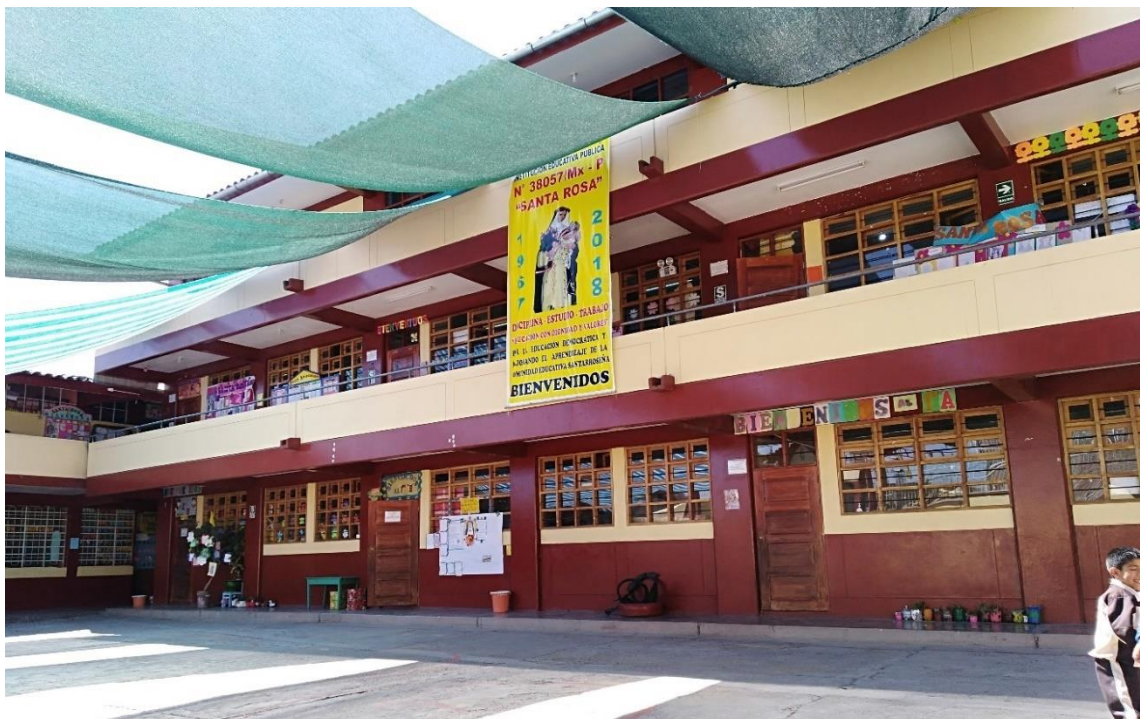
Figura N° 4. Instalaciones de la Institución Educativa N° 38057 "Santa Rosa" vista de lado derecho.
