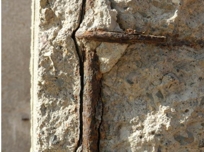
**Imagen N°08: Oxidación de armados.**
