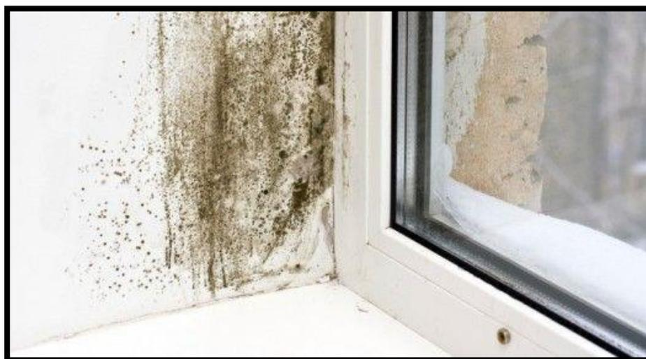
**Imagen N° 03: Humedad por condensación.**
