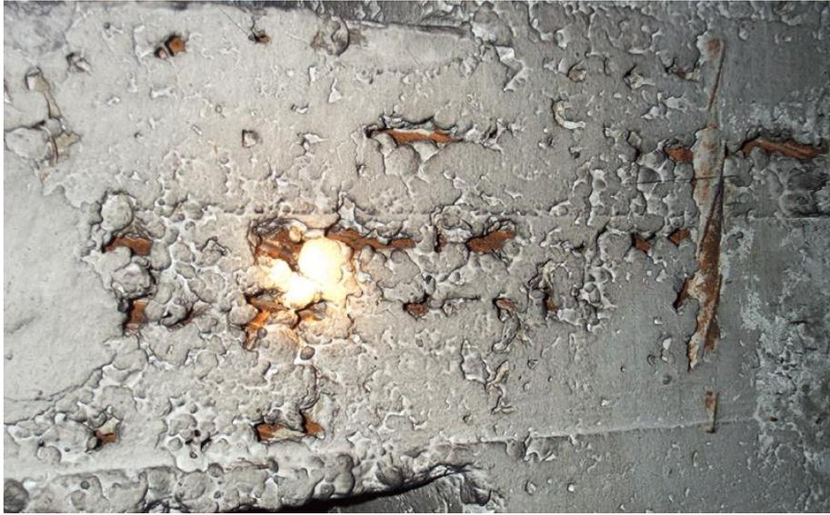
**Imagen N°09: Corrosión de armaduras.**
