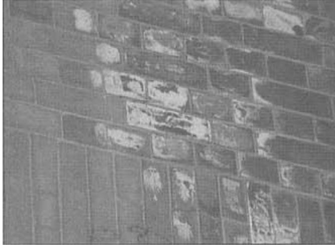
**Imagen N°07: Eflorescencia en una pared de ladrillo.**
