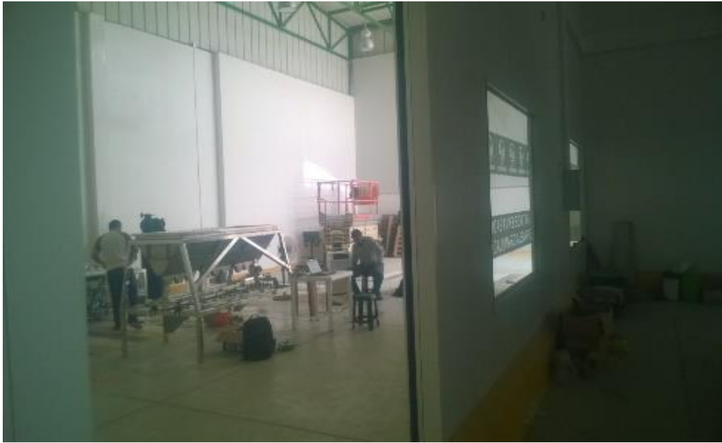
Instalación de maquinaria
