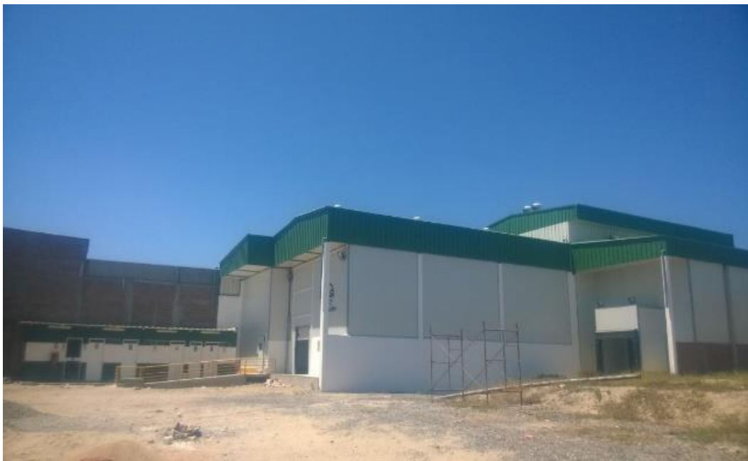
Planta de procesamiento de panela
