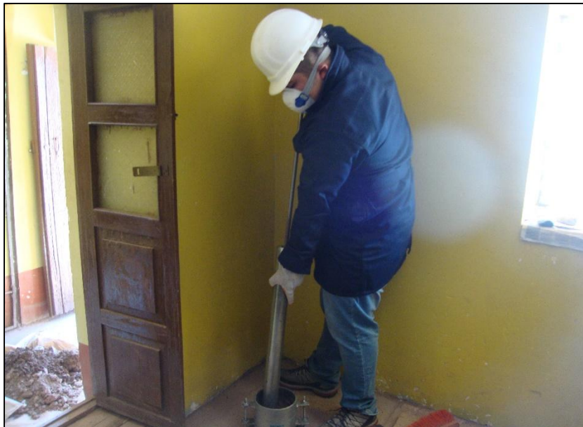
Fotografía 11: Proceso de compactación -Proctor modificado
