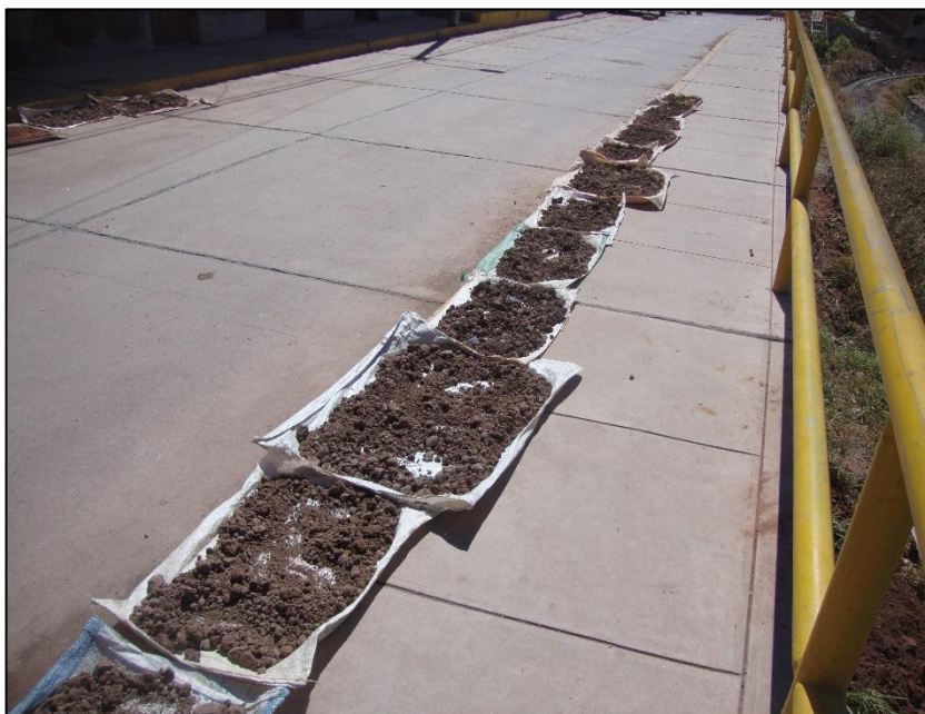
Fotografía 3: Secado del Material Granular
