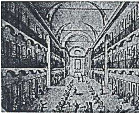
Vista interior San Miguel Roma Fuente: Implantación de Establecimientos Penitenciarios , Arquitecto Diego José Cánovas
