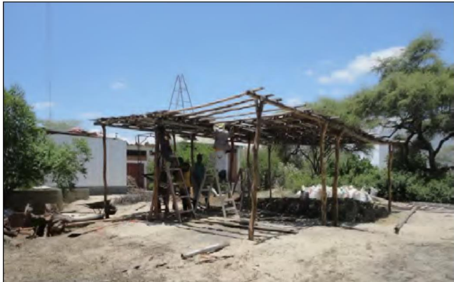
Foto N°5: Techo del compost.
