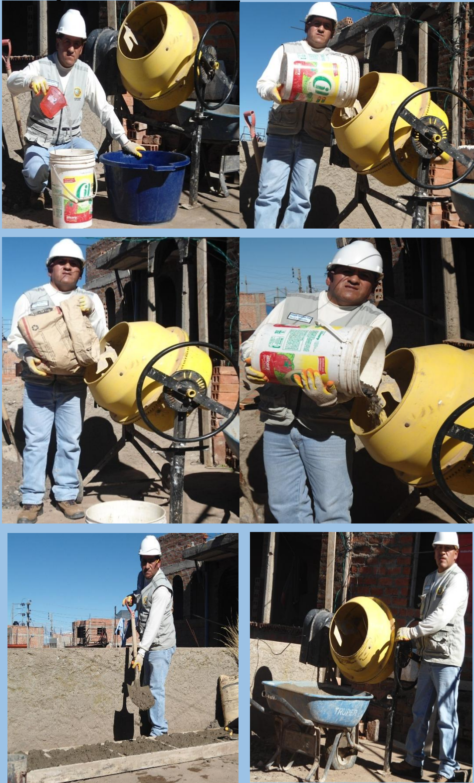
Imagen 38: Dosificación y colocado de la mezcla.
