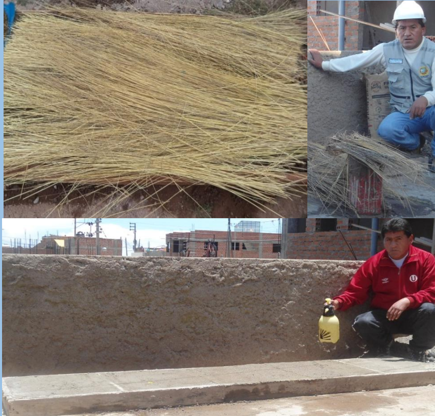
Imagen 40: Curado de concreto fresco con paja del altiplano.
