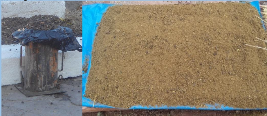
Imagen 39: Curado de concreto fresco con estiércol de corral.
