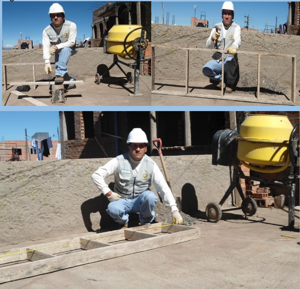
Imagen 36: Proceso constructivo de encofrado
