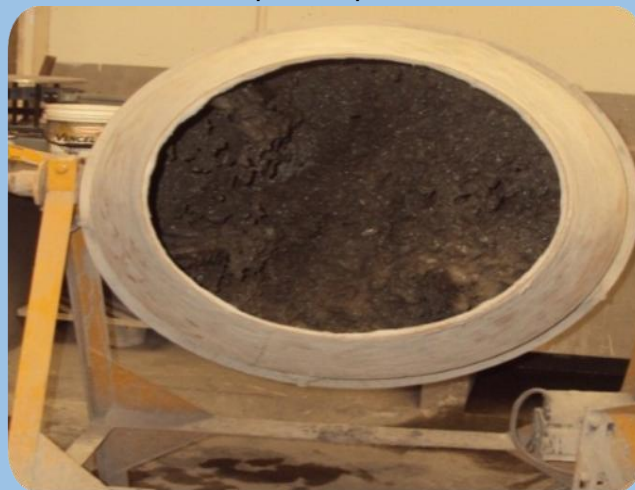
Mezclado de concreto tipo trompo
